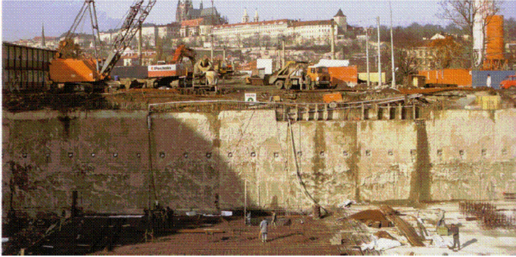
Slika 1. Građevna jama zaštićena usidrenom dijafragmom [13]
