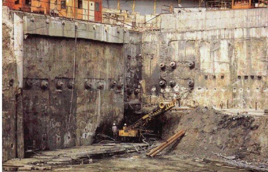
Slika 7. Armiranobetonska dijafragma s veznom gredom i sidrima [1]
