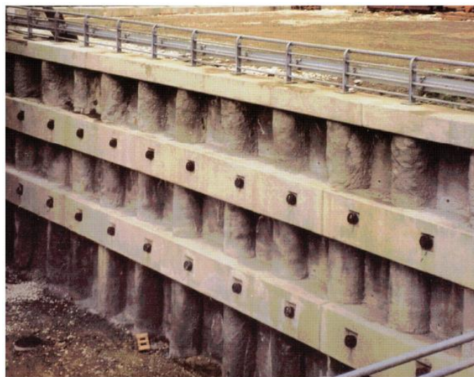
Slika 8. Otkopana stijenka izvedena metodom pilot do pilota s gredama i sidrima [1]
