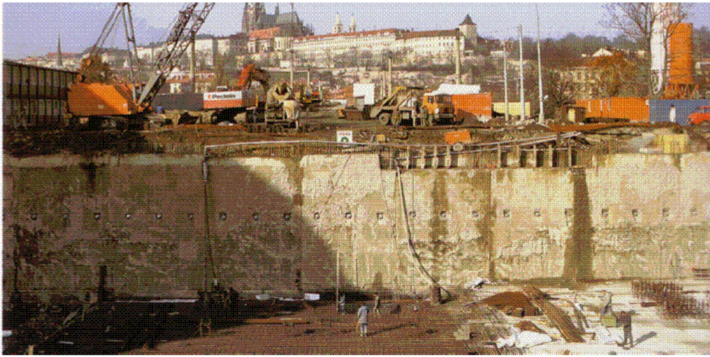
Slika 1. Građevna jama zaštićena usidrenom dijafragmom [13]
