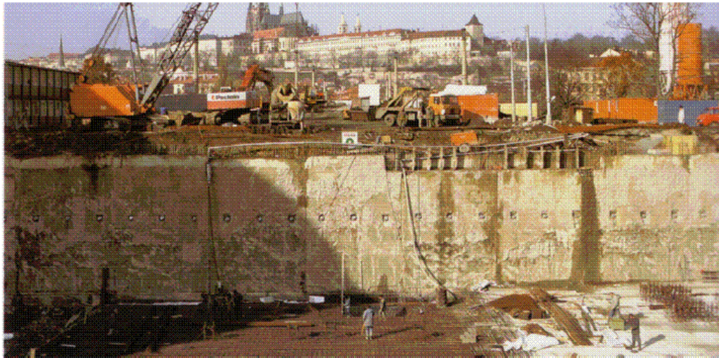
Slika 1. Građevna jama zaštićena usidrenom dijafragmom [13]
