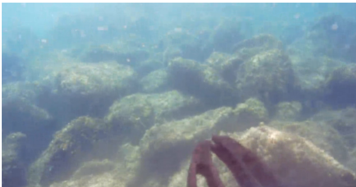
Slika 8.1.2. Podvodna fotografija postojećeg lukobrana napravljenog bespilotnom ronilicom
