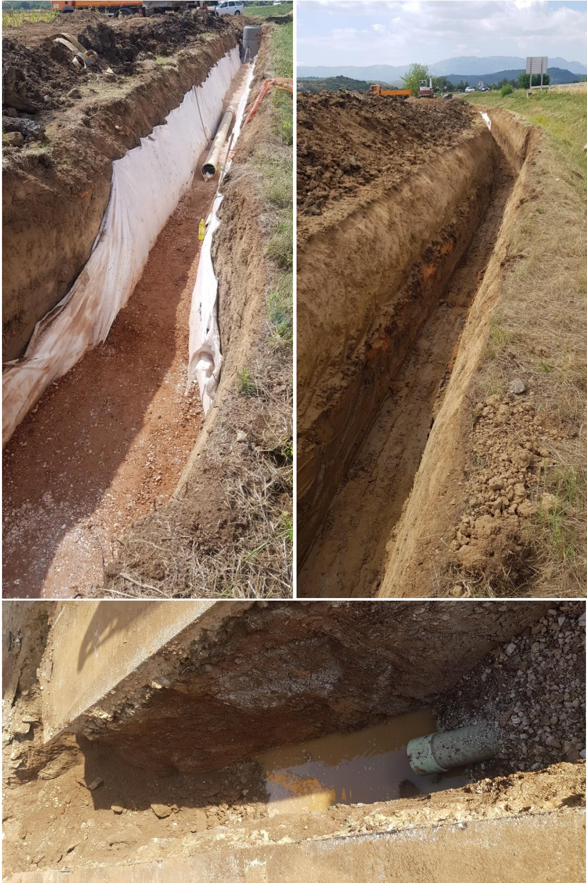
Fotografija 4., 5. i 6. iskop rova i postava geotekstila u mekanom tlu C kategorije
