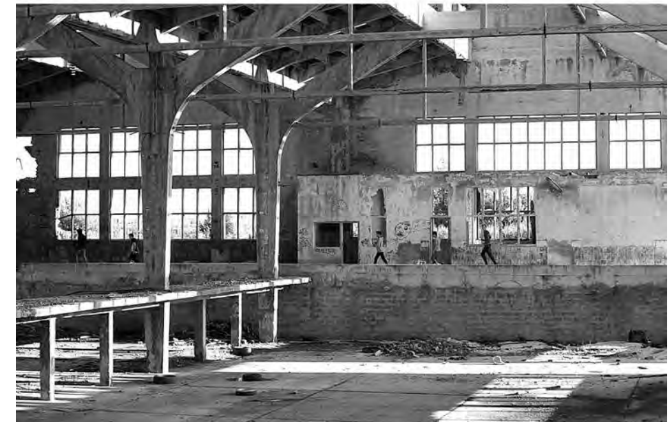
Obilazak lokacije / Site visit
