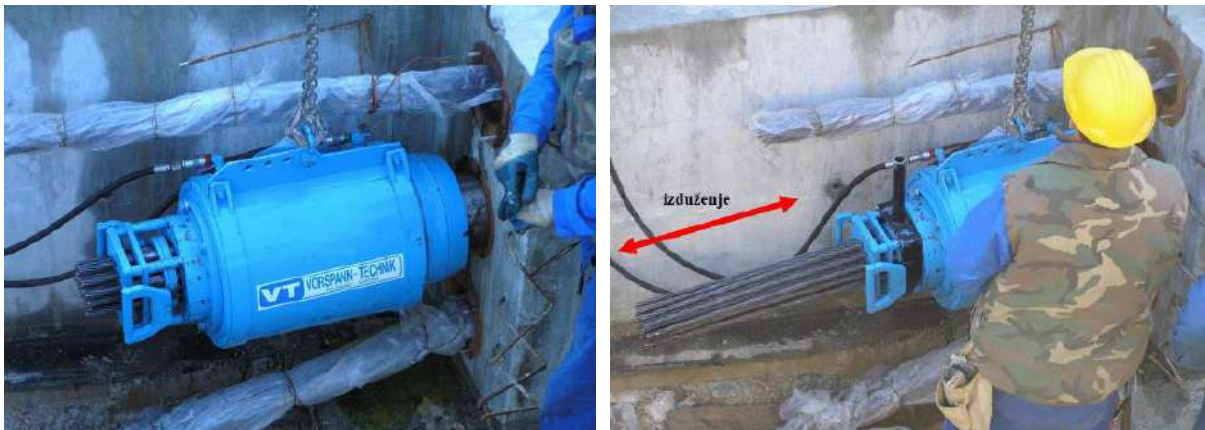
Slika 7.22 – Dvorana Višnjik – prednapinjanje temeljnog prstena [16]
