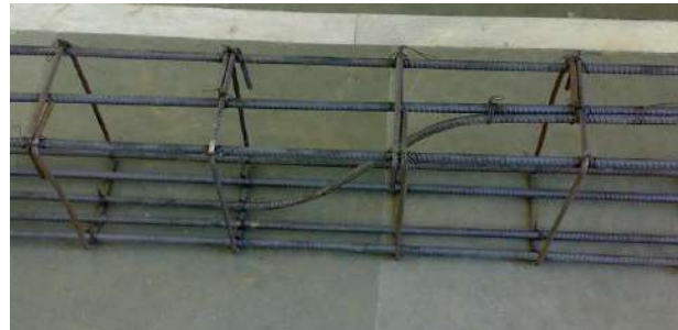
Slika 3.20 – Kosa armatura u armiranobetonskoj gredi
