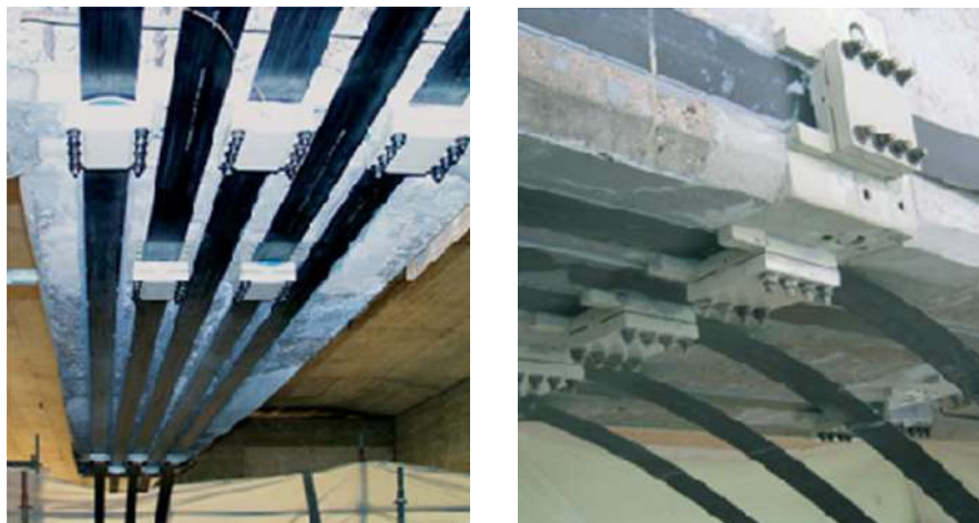
Slika 7.47 – Obnova mosta prednapetim karbonskim trakama
