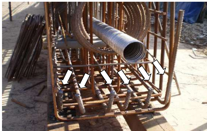
Slika 7.25 – Obitna armatura postavljena u armaturnom košu djelomično prednapetog nosača
