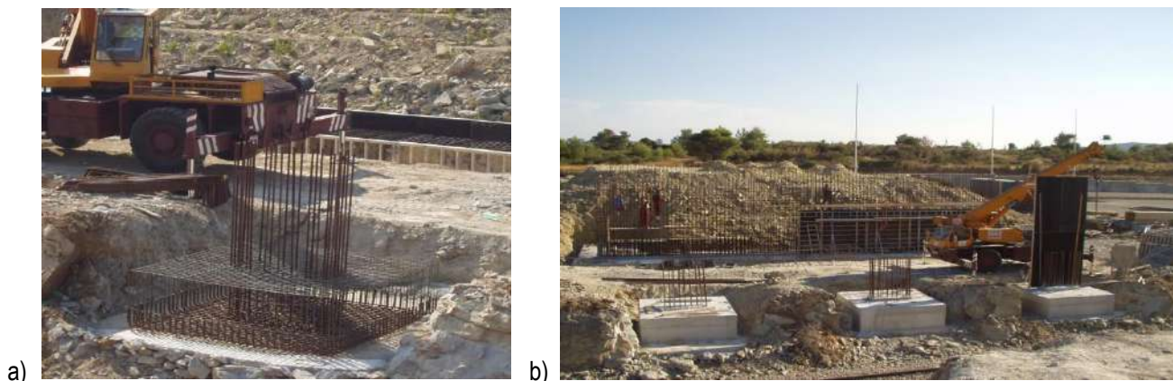
Slika 6.100 – Temelji samci - temelji stupova mosta Emmezeta, Kaštel Sućurac: a) armatura, b) izvedeni temelji
