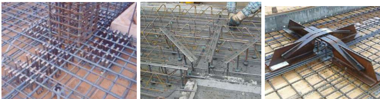
Slika 6.18 – Armatura protiv proboja ploče
