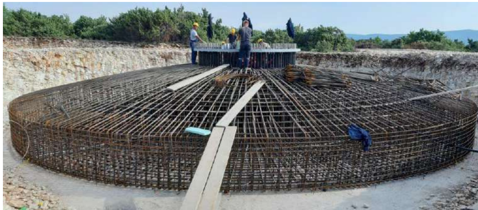
Slika 6.112 – Temelj stupa vjetroagregata, vjetroelektrana Korlat, kod Zadra
