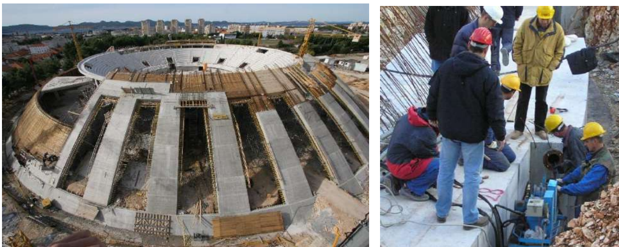
Slika 7.40 – Dvorana Višnjik – dvorana tijekom gradnje i uvlačenje užadi u cijev [16]
