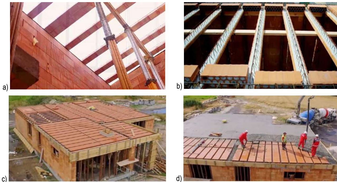
Slika 6.47 – Sustav Fert – Faze izvedbe Fert stropa
