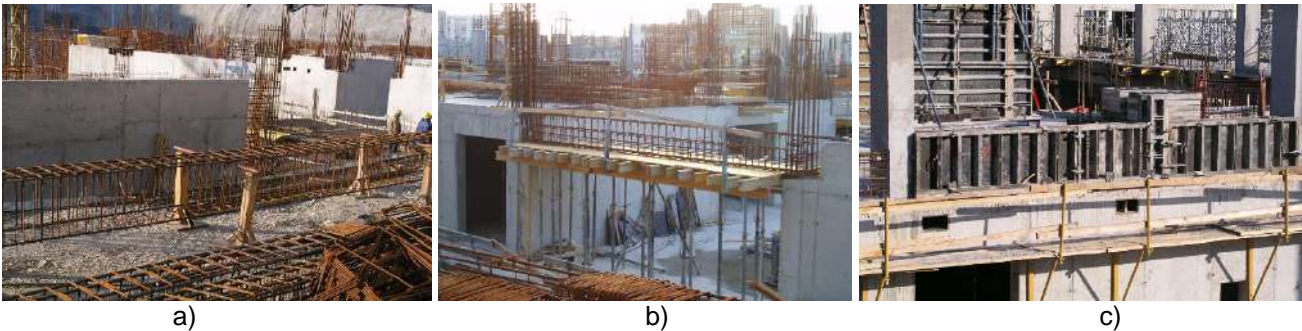
Slika 6.61 – Faze izvedbe grede
