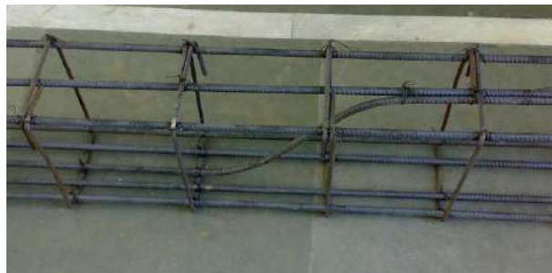
Slika 3.20 – Kosa armatura u armiranobetonskoj gredi
