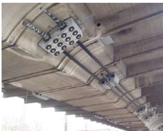
Slika 7.9 –Vanjsko prednapinjanje [20] & [21]
