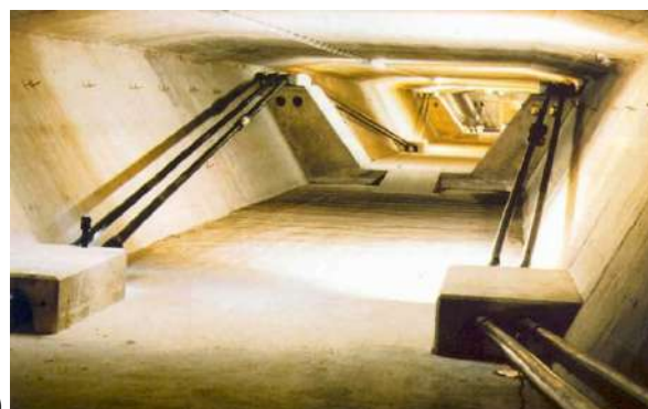
Slika 7.9 –Vanjsko prednapinjanje [20] & [21]
