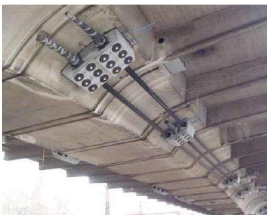
Slika 7.9 –Vanjsko prednapinjanje [20] & [21]
