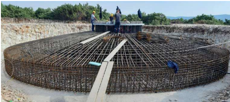
Slika 6.112 – Temelj stupa vjetroagregata, vjetroelektrana Korlat, kod Zadra
