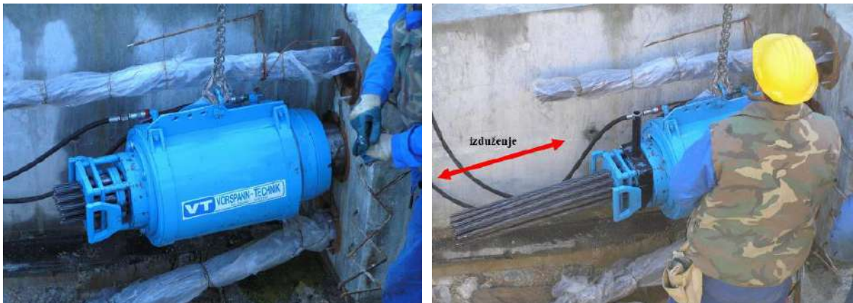
Slika 7.22 – Dvorana Višnjik – prednapinjanje temeljnog prstena [16]
