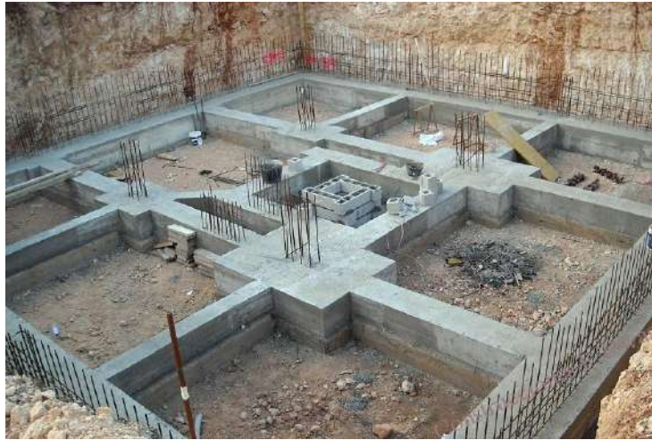
Slika 6.101 – Temelji samci ispod stupova i temeljne trake ispod zidova - temelji samci povezani temeljnim gredama
