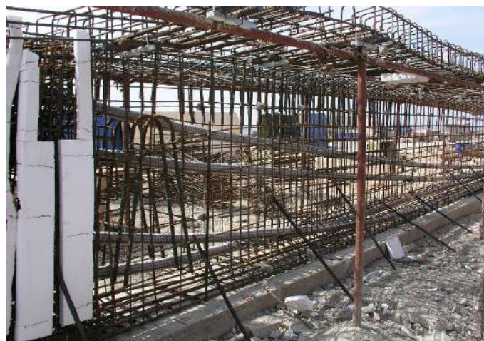
Slika 7.8 –Unutarnje prednapinjanje
