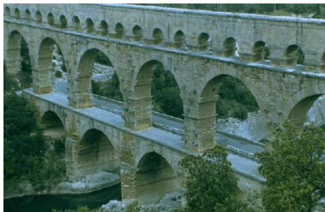
Slika 1.2 – Akvadukt Pont du Gard
