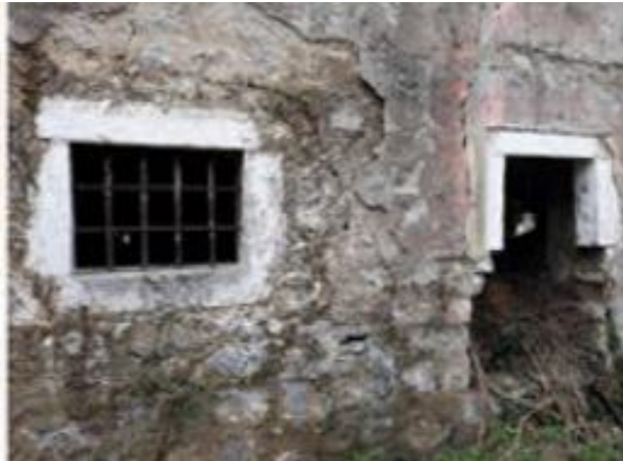
42) Detalj sjeverne fasade
