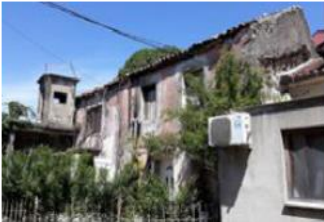
51) Jugoistočni izgled sa kulicom
