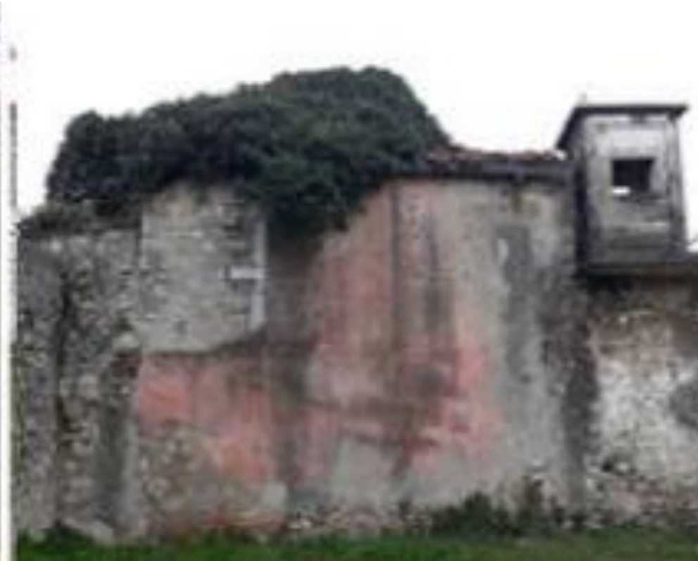
54) Zapadni izgled-ogradni zid kompleksa
