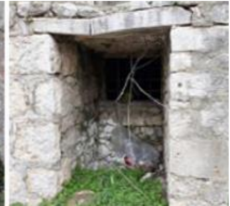
43) Detalj otvora ispod podesta
