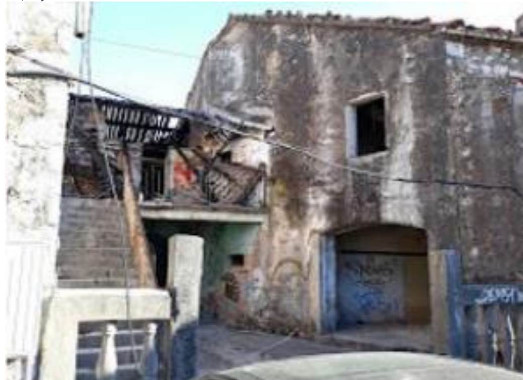
47) Južno krilo-sjeverna fasada sa ulazom
