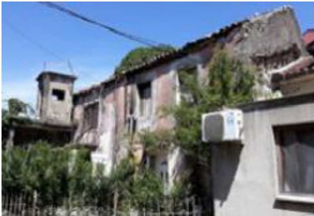
51) Jugoistočni izgled sa kulicom
