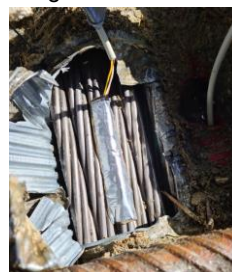
Slika 6. Mjerni senzori na betonu i prednapetom čeliku
