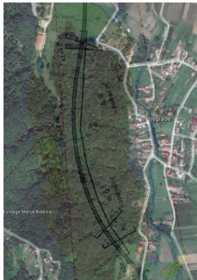
Slika 1. Prikaz tunela Podgrađe u programu Google Earth
