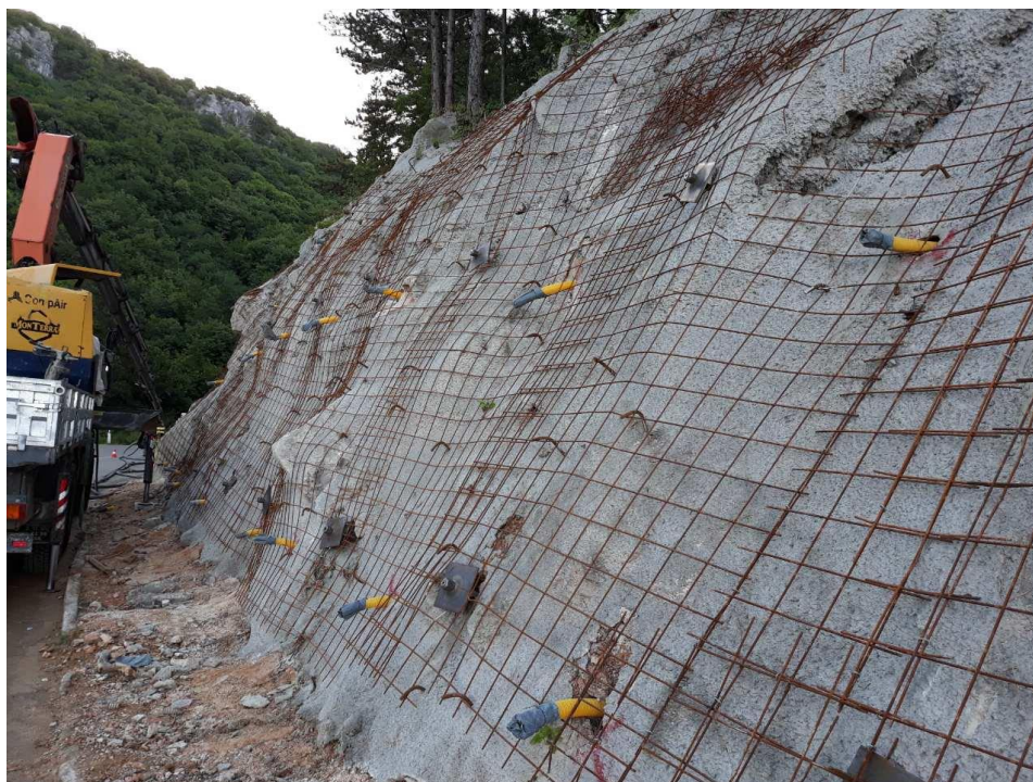
Slika 31. Zaštita kosine armaturnim mržama na padinama. [14]
