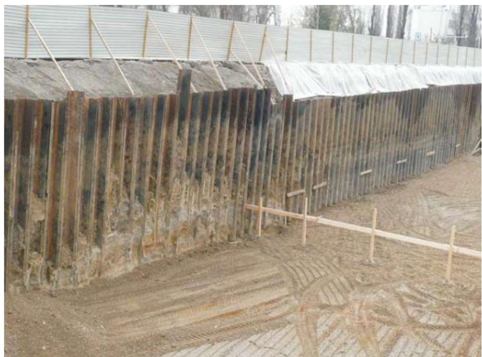
Slika 14. Primjer zaštite čeličnim žmurjem
