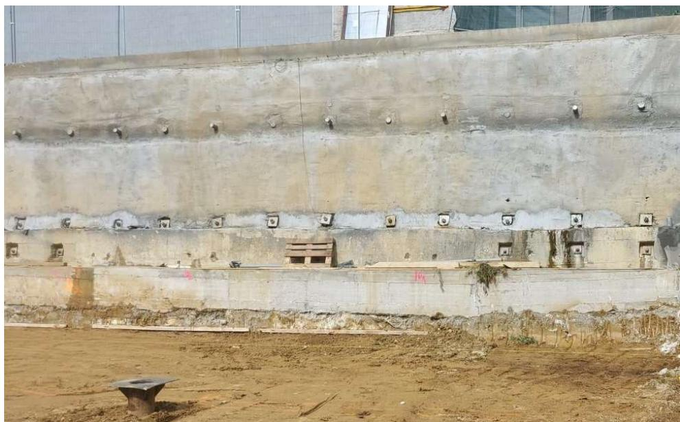
Slika 6. Armirano - betonska dijafragma s pripadajućim ojačanjem
