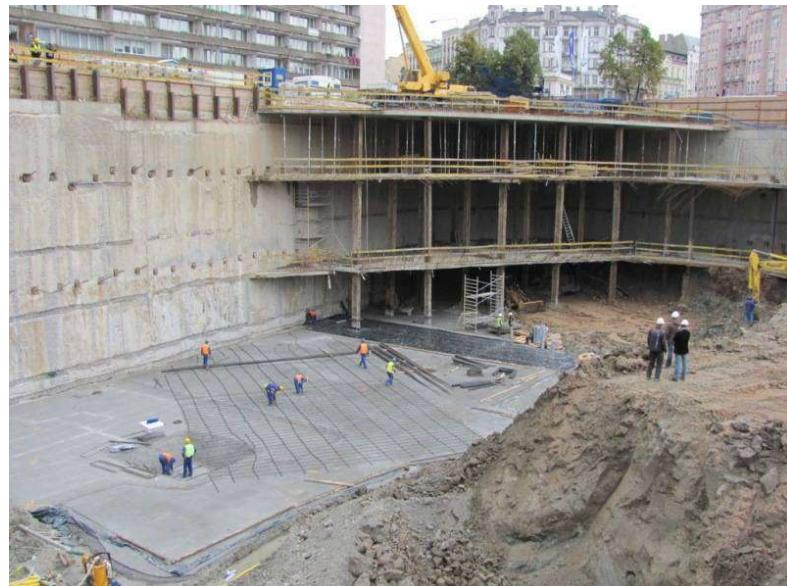
*Slika 3. Primjer armirano – betonske dijafragme*
