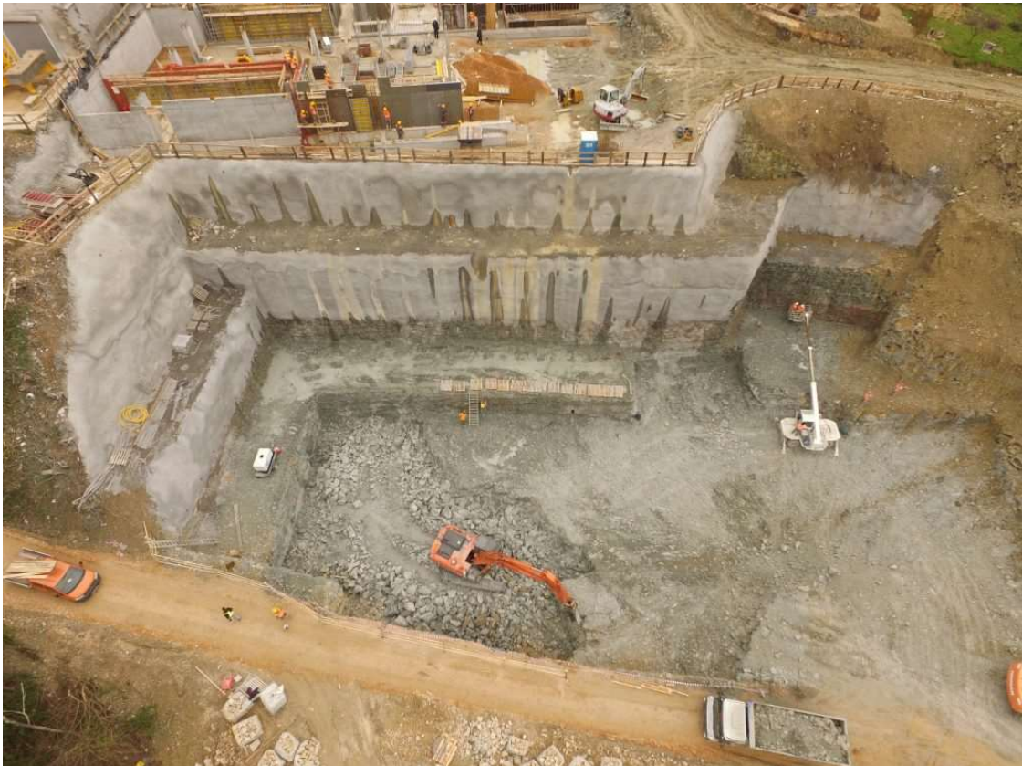
Slika 2. Primjer građevne jame
