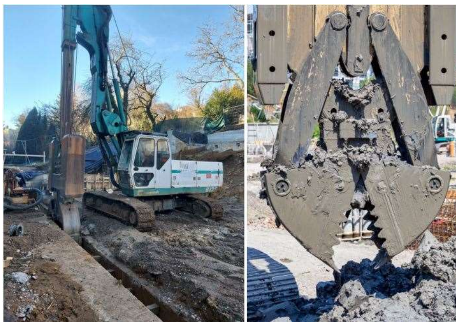
Slika 5. Mehanička grabilica
