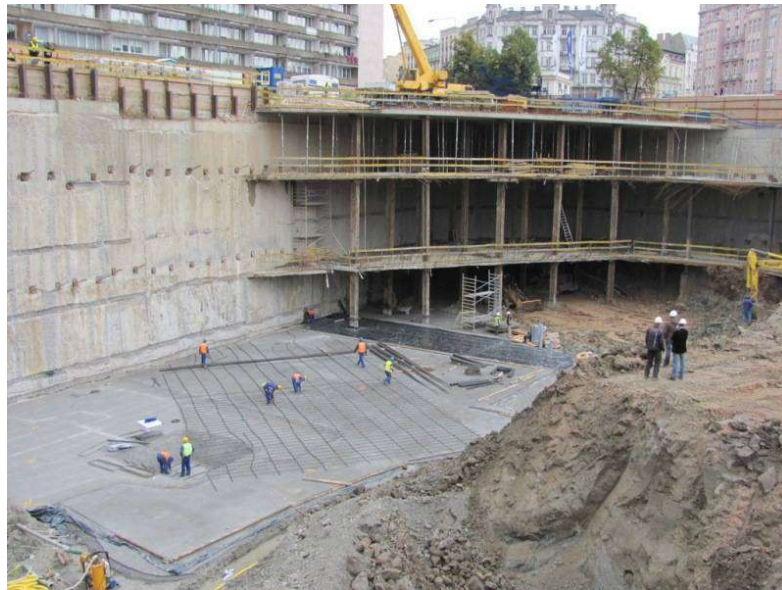
Slika 3. Primjer armirano – betonske dijafragme
