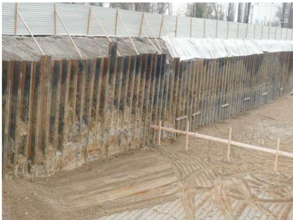
Slika 14. Primjer zaštite čeličnim žmurjem
