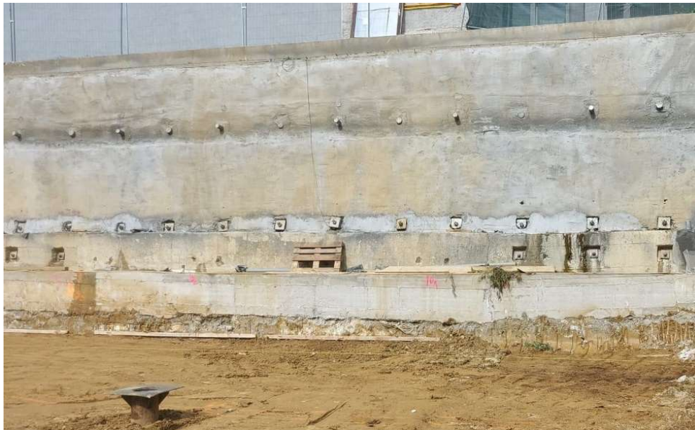
Slika 6. Armirano - betonska dijafragma s pripadajućim ojačanjem
