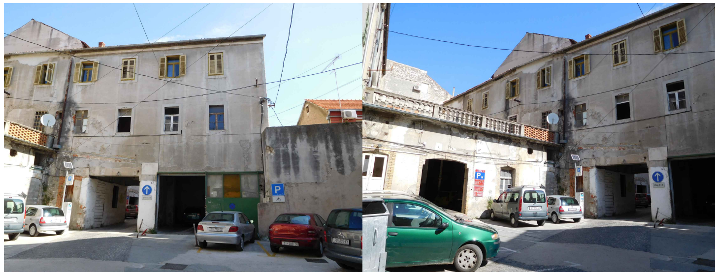
Slika 37. Zgrada D- Južno pročelje
