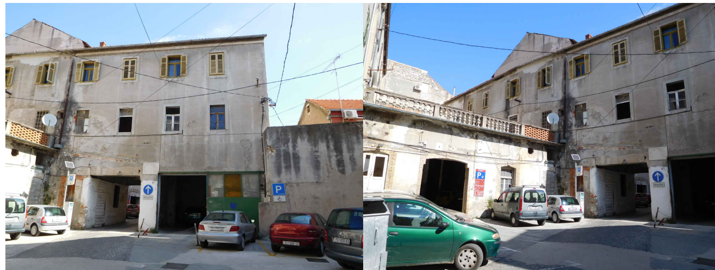
Slika 37. Zgrada D- Južno pročelje
