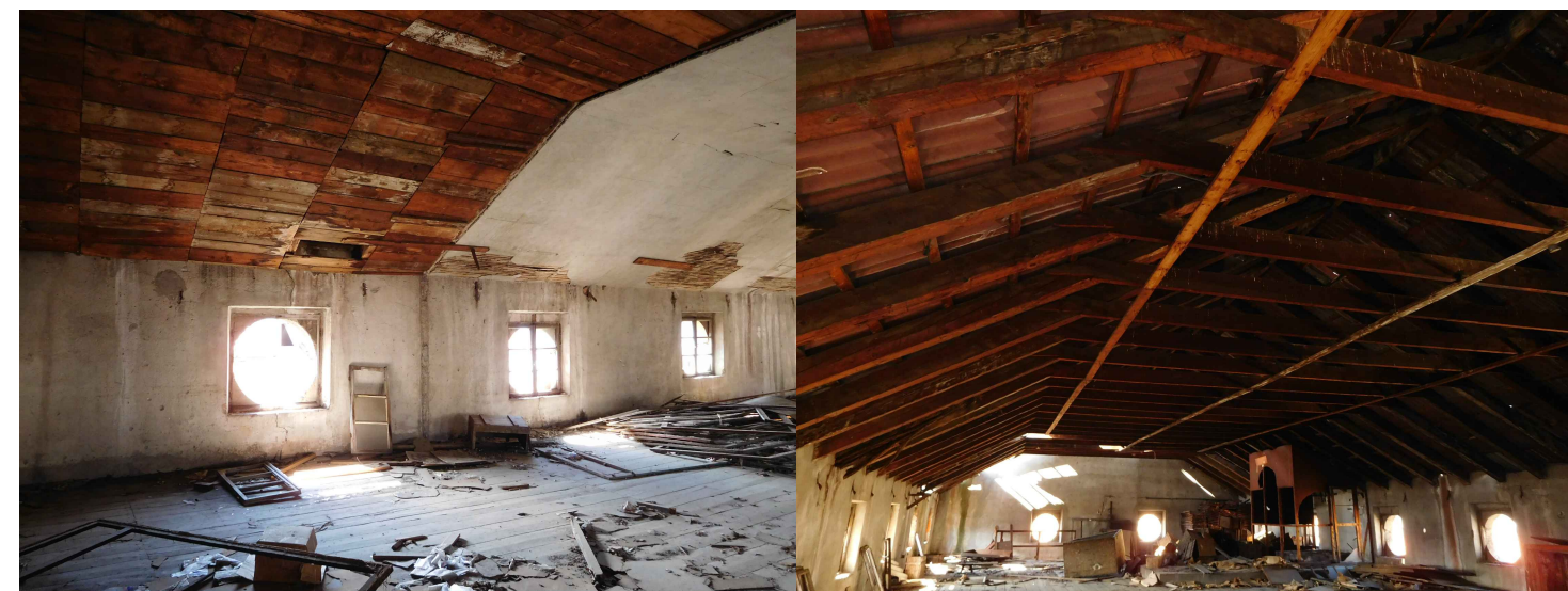
Slika 41.; 42. Podkrovlje zgrade A - trenutno stanje
