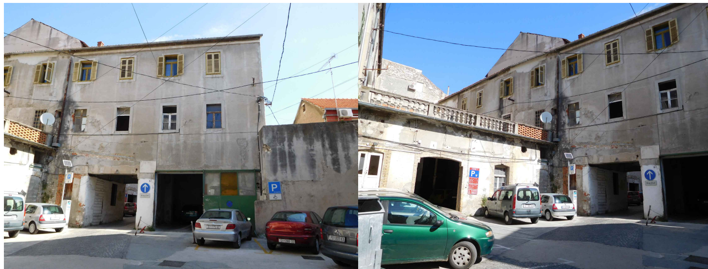
Slika 37. Zgrada D- Južno pročelje
