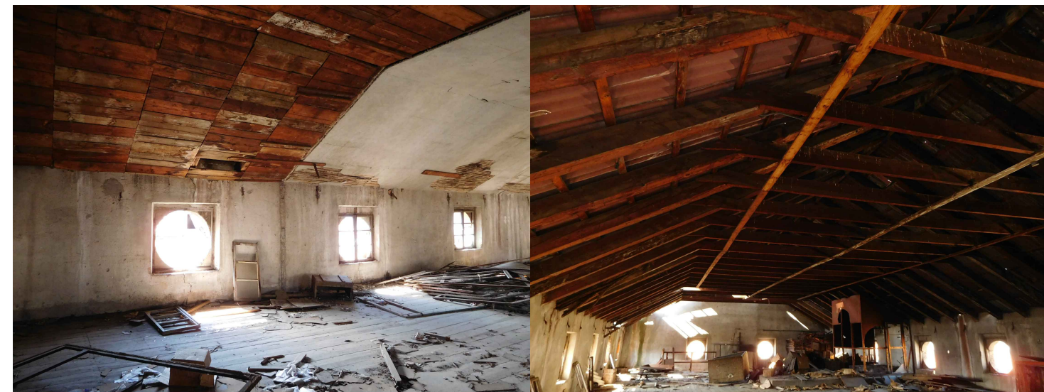
Slika 41.; 42. Podkrovlje zgrade A - trenutno stanje
