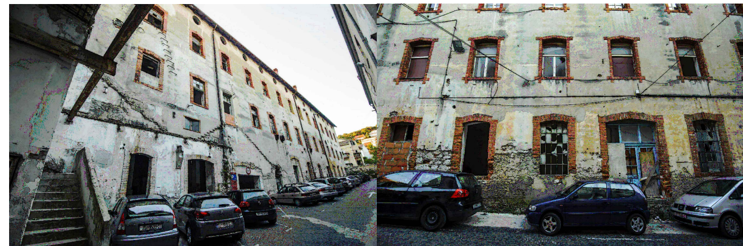
Slika 43.; 44. Dvorište kompleksa - trenutno stanje
