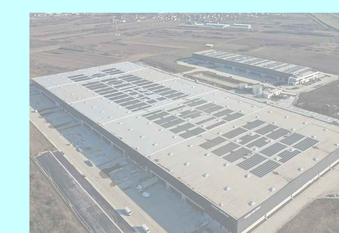
SOLARNE PLOČE NA KROVU
