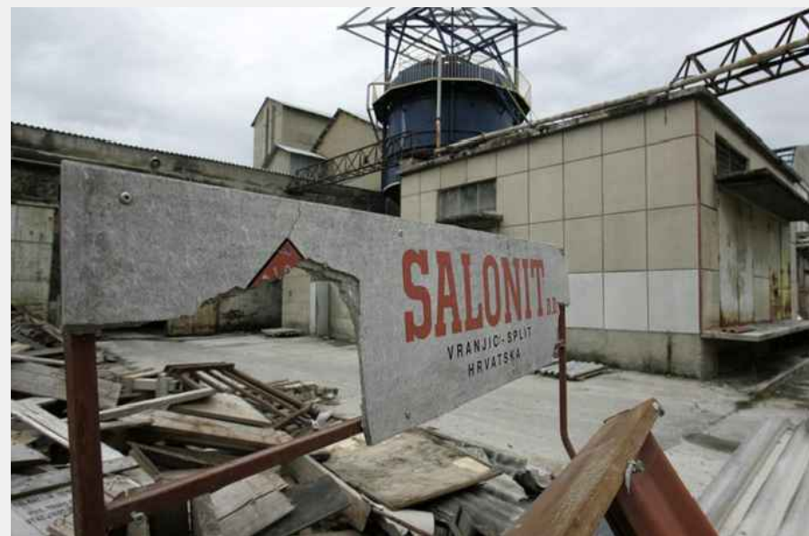
Danas zapuštena tvornica azbest-cementnih proizvoda "Salonit" u Vranjicu [ https://static.slobodnadalmacija.hr/images/slike/2022/10/25/9688273.jpg ]
