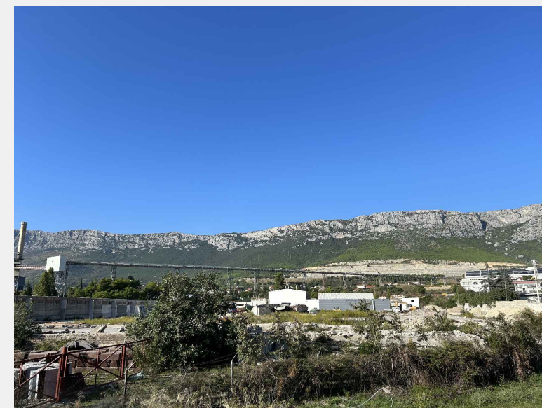
pogled s obalne linije na pokretnu traku
