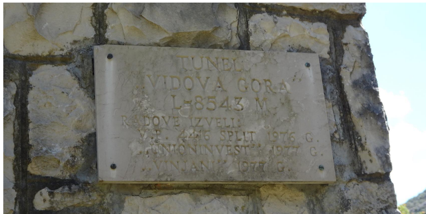
Slika 16: tunel Vidova gora
