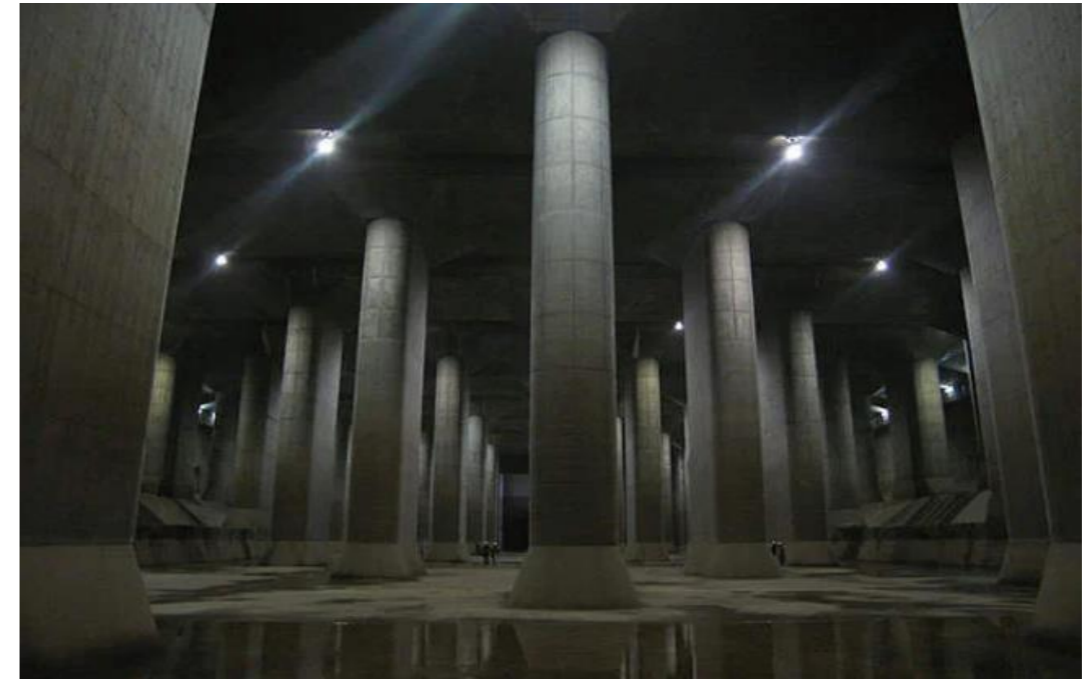
slika 8 – Prepumpna kontrolna stanica u sustavu G-Cans
