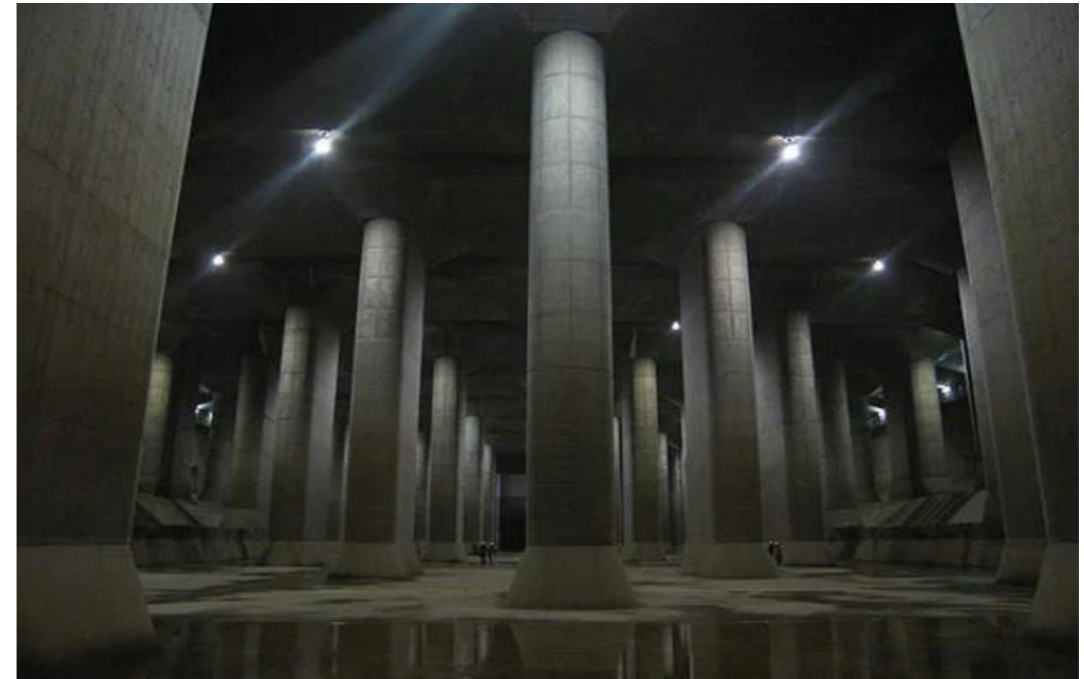
slika 8 – Prepumpna kontrolna stanica u sustavu G-Cans
