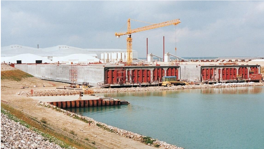
Slika 3. Primjer PERI oplate u izgradnji betonskih segmenata za podvodni tunel Oeresund [4]
