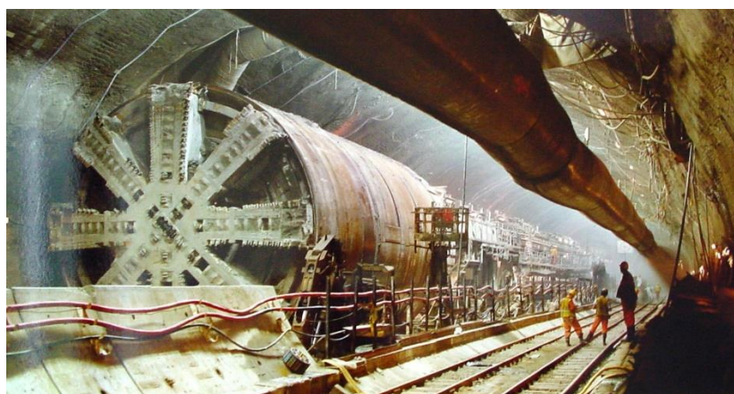
Slika 2. Primjer probijanja tunela [3]
