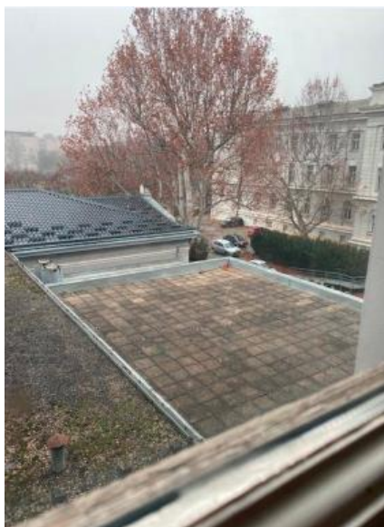
Slika 28: Ravni krov nad objektom za sanaciju [15]
