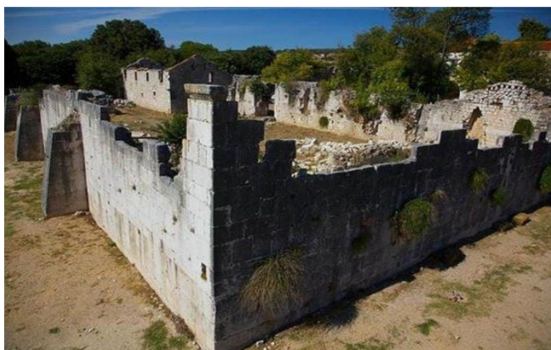
Slika 33: Han Jusufa Maškovića prije rekonstrukcije [17]
