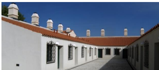
Slika 35: Prizemna građevina s jednostrešnim krovom [18]
