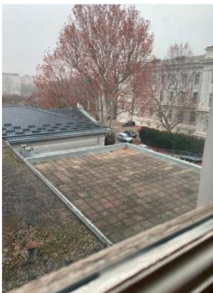
Slika 28: Ravni krov nad objektom za sanaciju [15]
