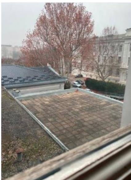
Slika 28: Ravni krov nad objektom za sanaciju [15]
