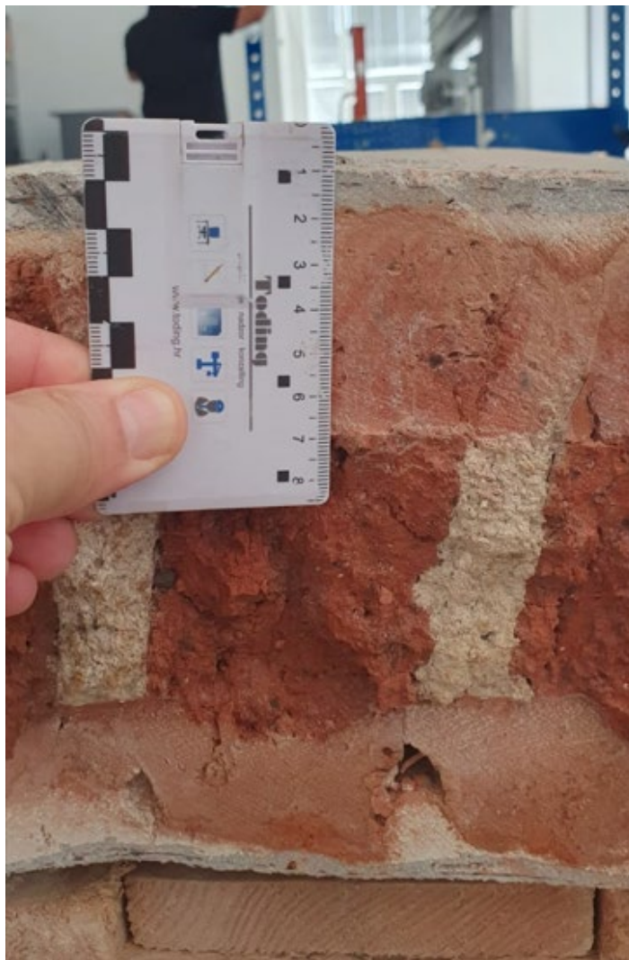
Fotografija 2.8 – Mjerenje debljine sloja karbonskog platna i morta
