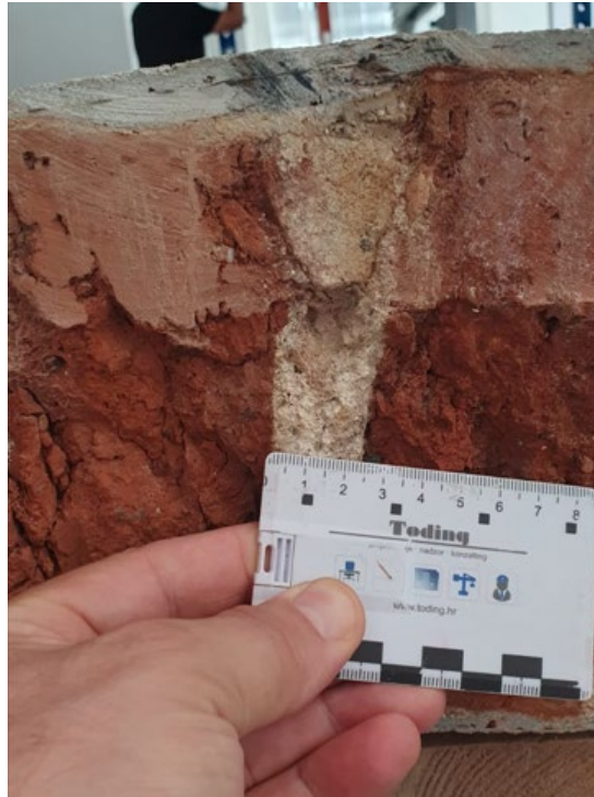
Fotografija 2.6 – Mjerenje debljine fuge
