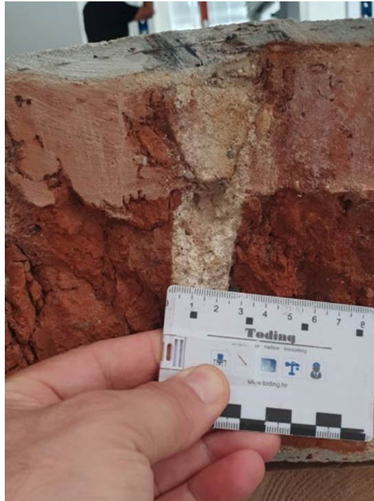
Fotografija 2.6 – Mjerenje debljine fuge
