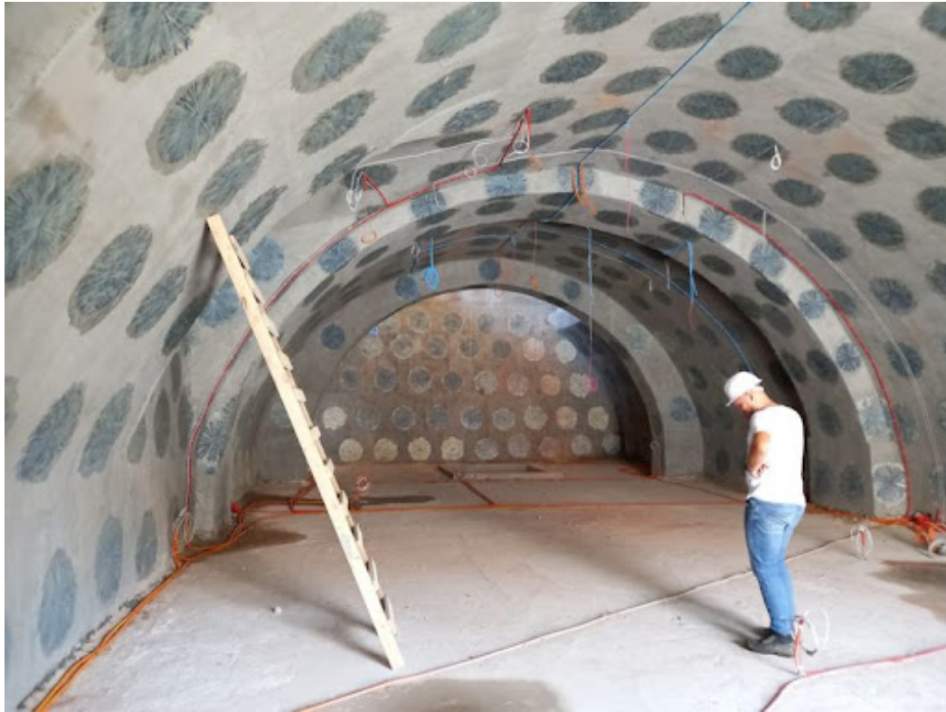
Fotografija 1.14 – Ojačanje svoda karbonskim tkaninama (vidljiva sidra od karbonskih užadi)
