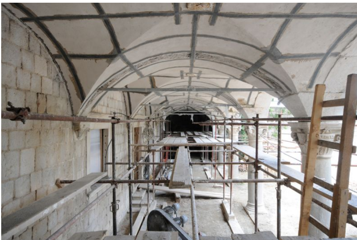
Fotografija 1.13 – Ojačanje svodova po intradosu
