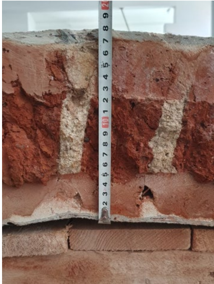
Fotografija 2.5 – Mjerenje debljine svoda
