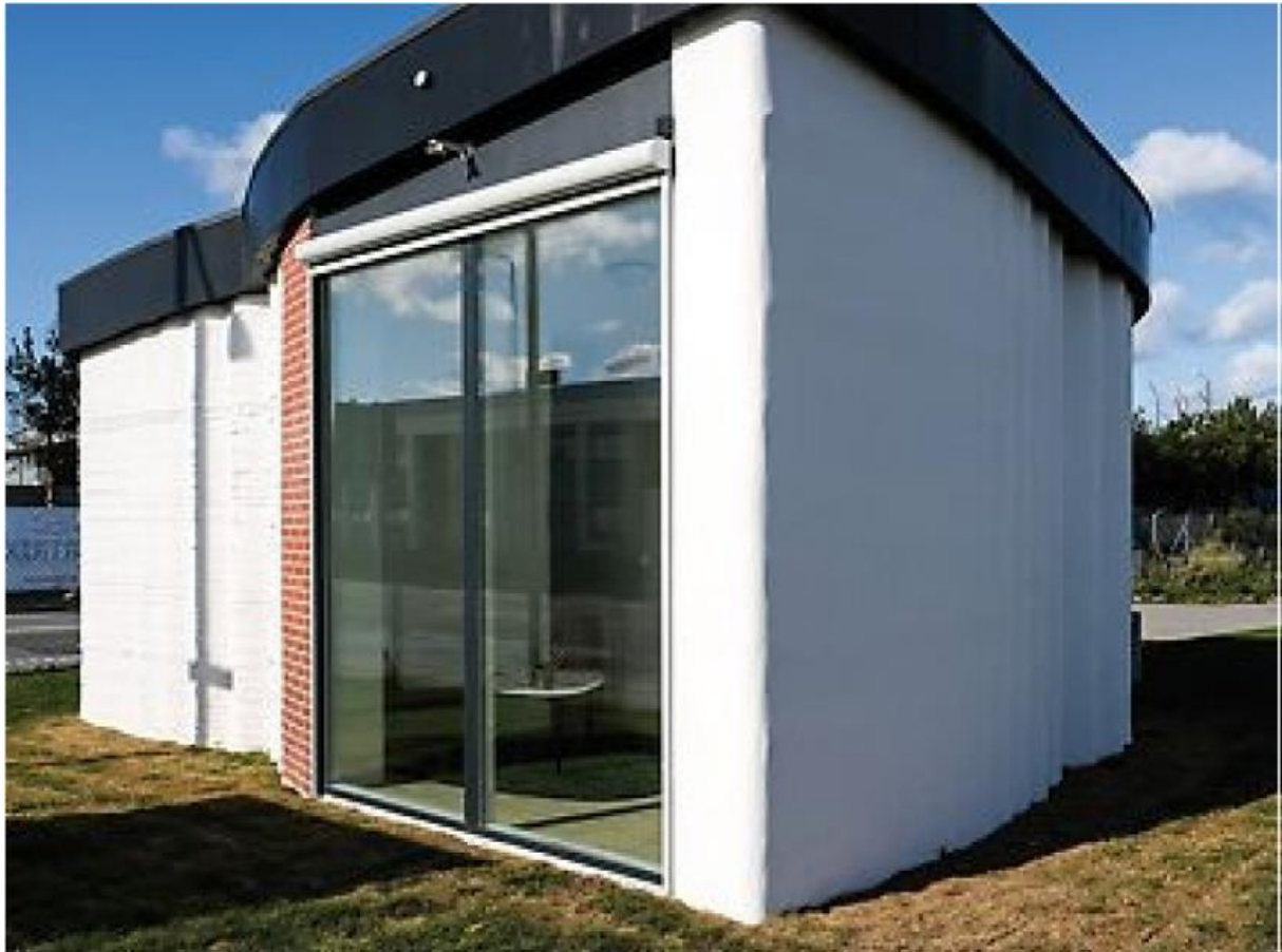
Slika 5: Kuća u Danskoj sa zakrivljenim 3D printanim zidovima (izvor: Milad Bazli, Hamed Ashrafi, Ali Rajabipour, Cat Kutay, 3D printing for remote housing: Benefits and challenges, Automation in Construction, 2023.)
