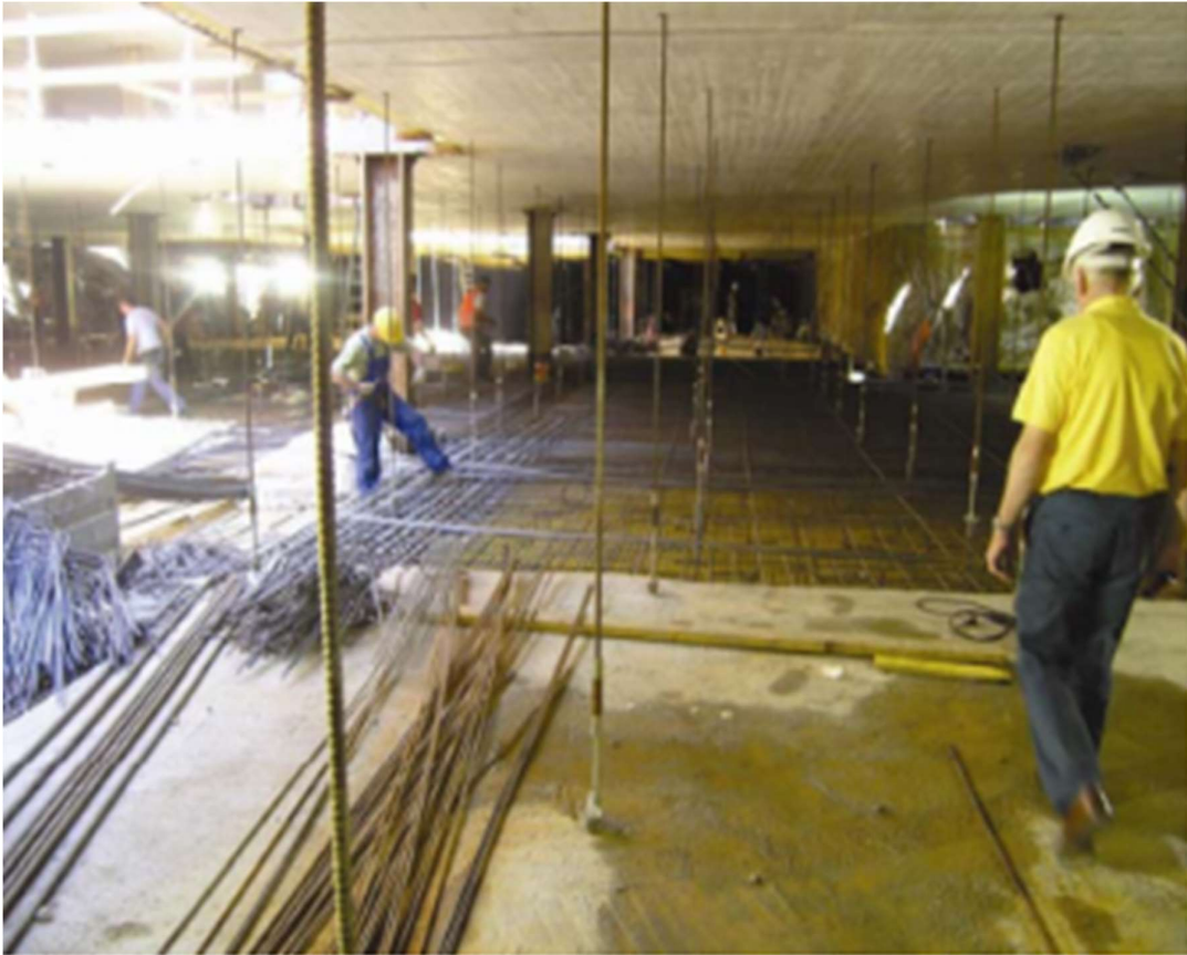
Slika 3.14 Viseći oplatni stolovi [1]
