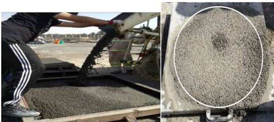
Slika 5.10: a) izlivanje betona na mjestu ugradnje (lijevo); b) rasprostiranje slijeganjem-ispitivanje na terenu (desno)[17]
