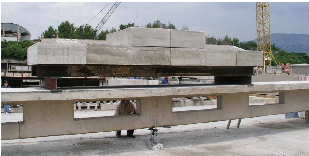
Slika 3.5. III faza opterećenja (8 betonskih blokova)
