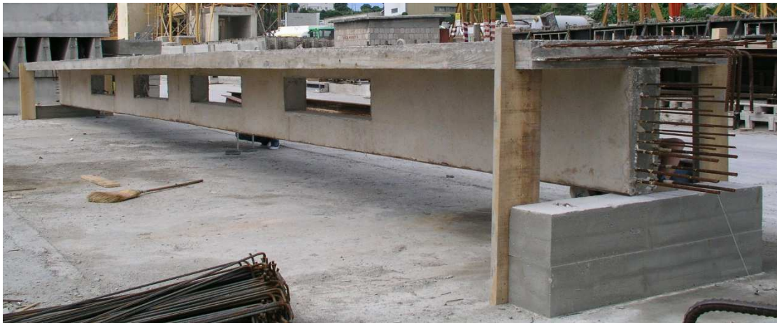
Slika 3.1. Nosač montiran na oslonce na mjestu ispitivanja
