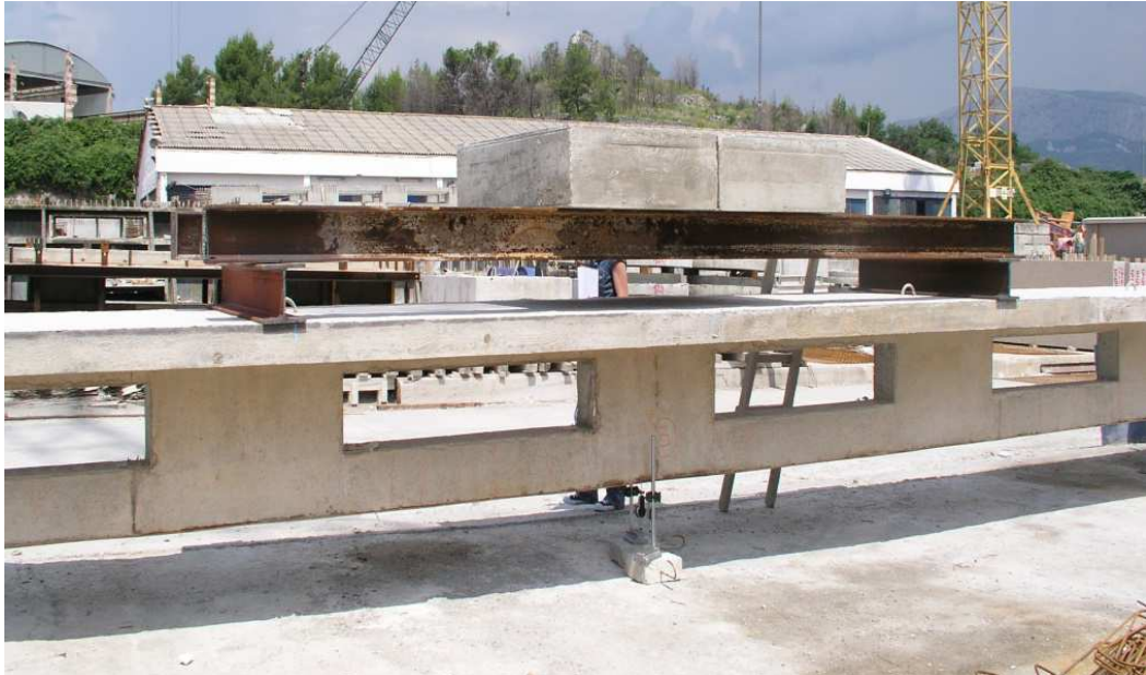
Slika 3.4. II faza opterećenja (2 betonska bloka)
