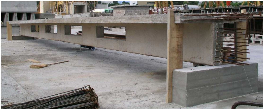
Slika 3.1. Nosač montiran na oslonce na mjestu ispitivanja
