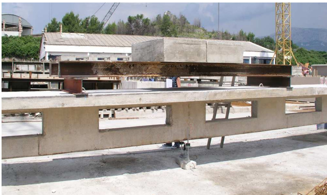
Slika 3.4. II faza opterećenja (2 betonska bloka)
