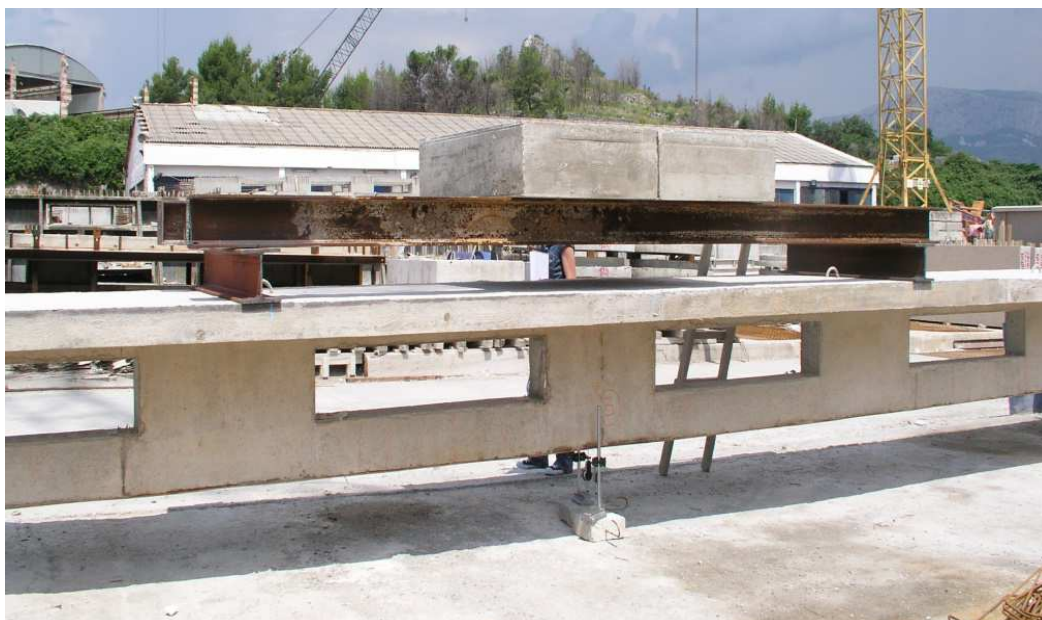
Slika 3.4. II faza opterećenja (2 betonska bloka)
