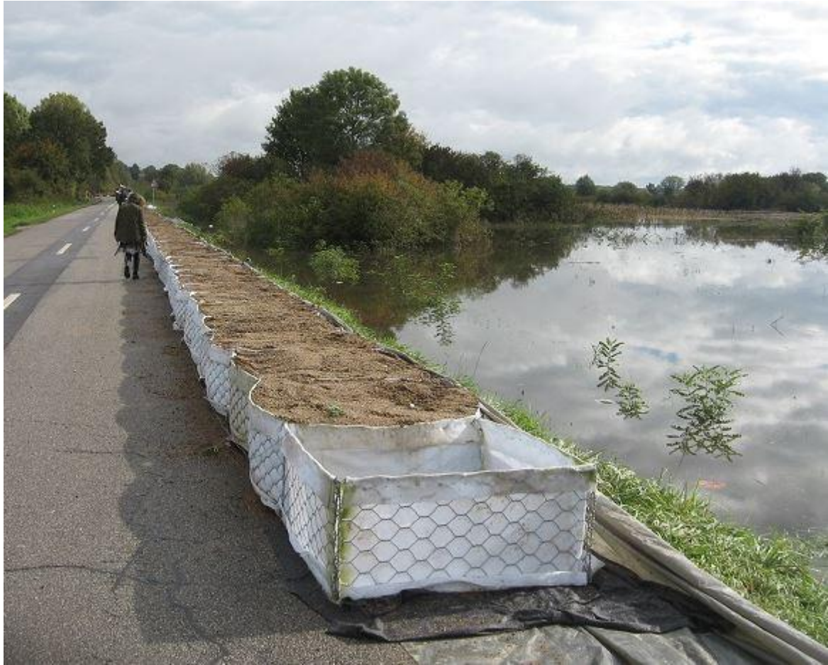
Slika 2. Prikaz stanja prometnice za vrijeme poplave
