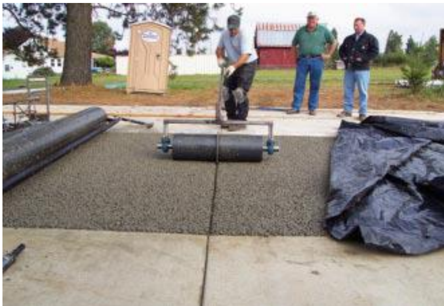
Slika 2.12 Upotreba valjka za oblikovanje dilatacijskih reški [9]
