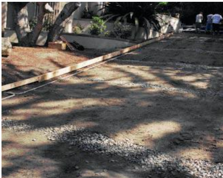
Slika 2.7 Priprema podloge kod ugradnje kolnika pod kutom [9]
