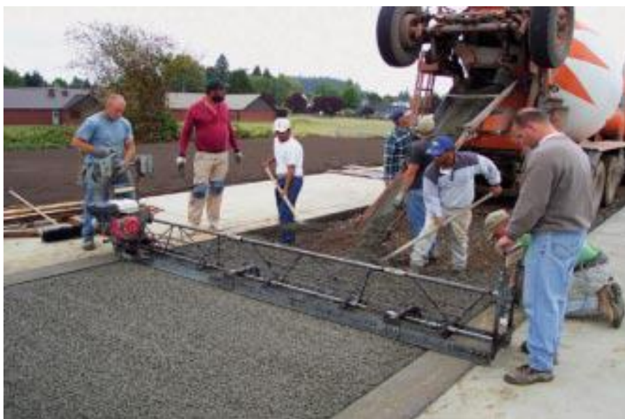
Slika 2.9 Upotreba vibrirajuće ravnalice [9]
