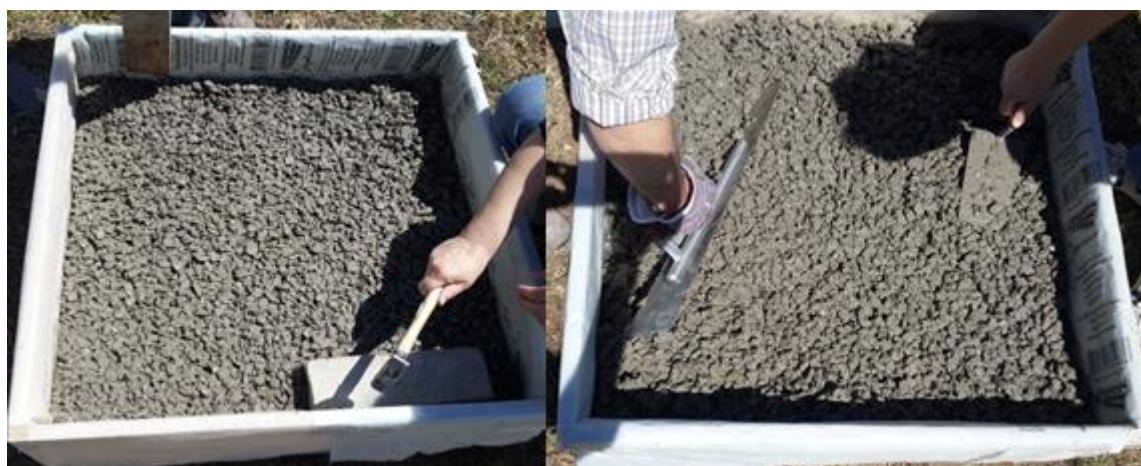
Slika 4.24 Ugradnja porozno – betonskih ploča
