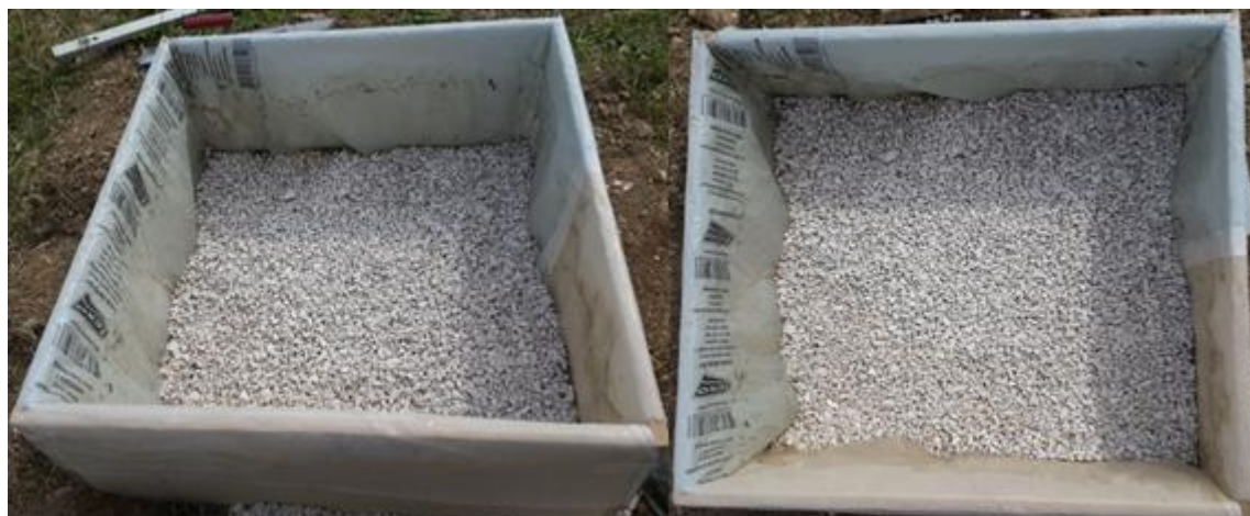
Slika 4.23 Šljunčana podloga
