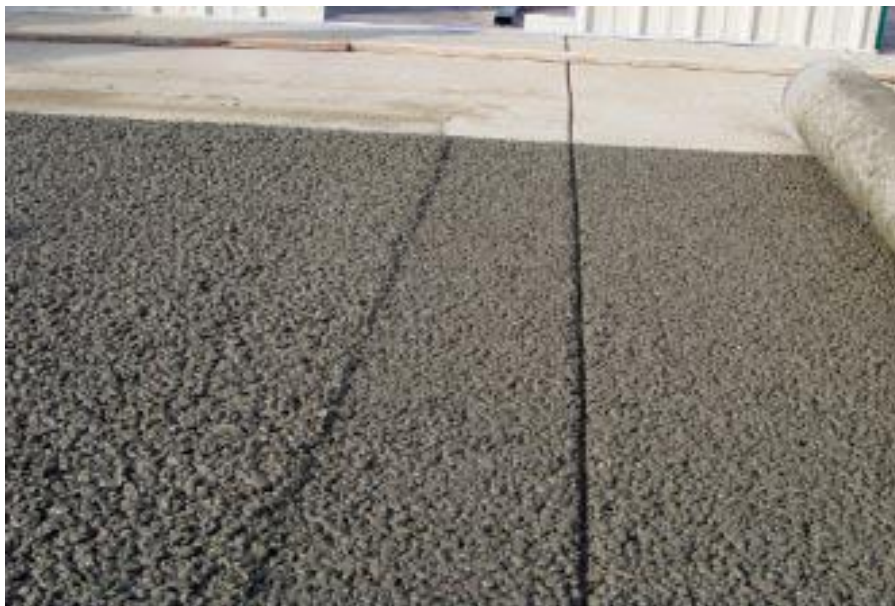
Slika 2.10 Porozni beton nakon ravnanja (lijevo) i nakon zbijanja (desno) [9]
