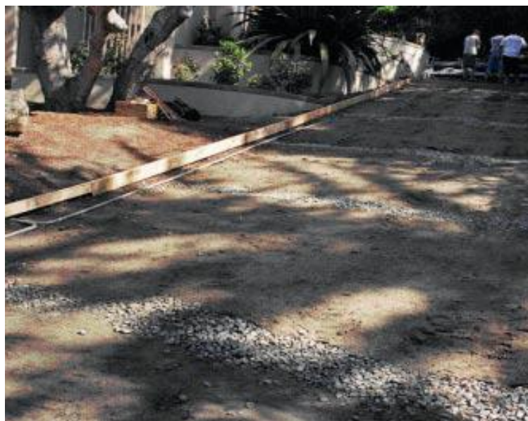
Slika 2.7 Priprema podloge kod ugradnje kolnika pod kutom [9]
