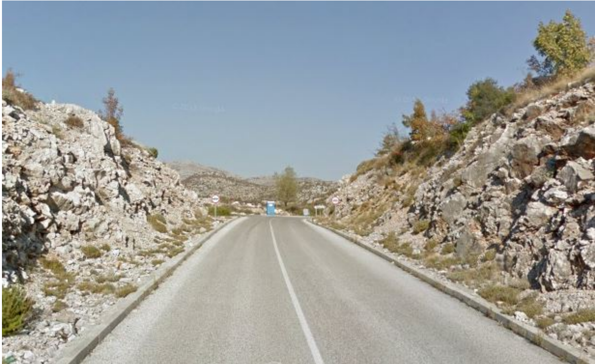
Slika 1. Prikaz postojećeg stanja prometnice OS 1
