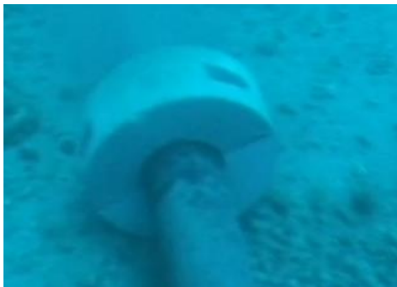
Slika 12. Detalj primarnog opteživača na novoj dionici postavljenoj 2008. godine
