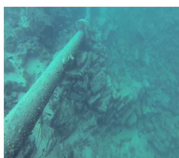
Slika 20. Detalj podzide izvedene na ulasku podmorskog ispusta u rov
