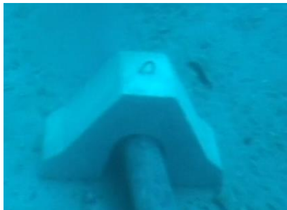
Slika 13. Detalj sekundarnog opteživača na novoj dionici cjevovoda podmorskog ispusta postavljenoj 2008. godine
