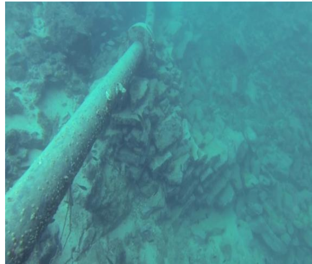
Slika 20. Detalj podzide izvedene na ulasku podmorskog ispusta u rov
