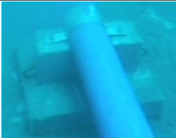
Slika 3. Detalj betonskog podmetača difuzora
