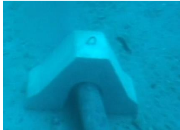
Slika 13. Detalj sekundarnog opteživača na novoj dionici cjevovoda podmorskog ispusta postavljenoj 2008. godine
