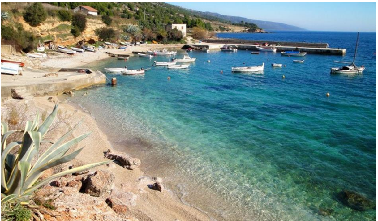
Slika 2.3. Pogled na postojeći lukobran
