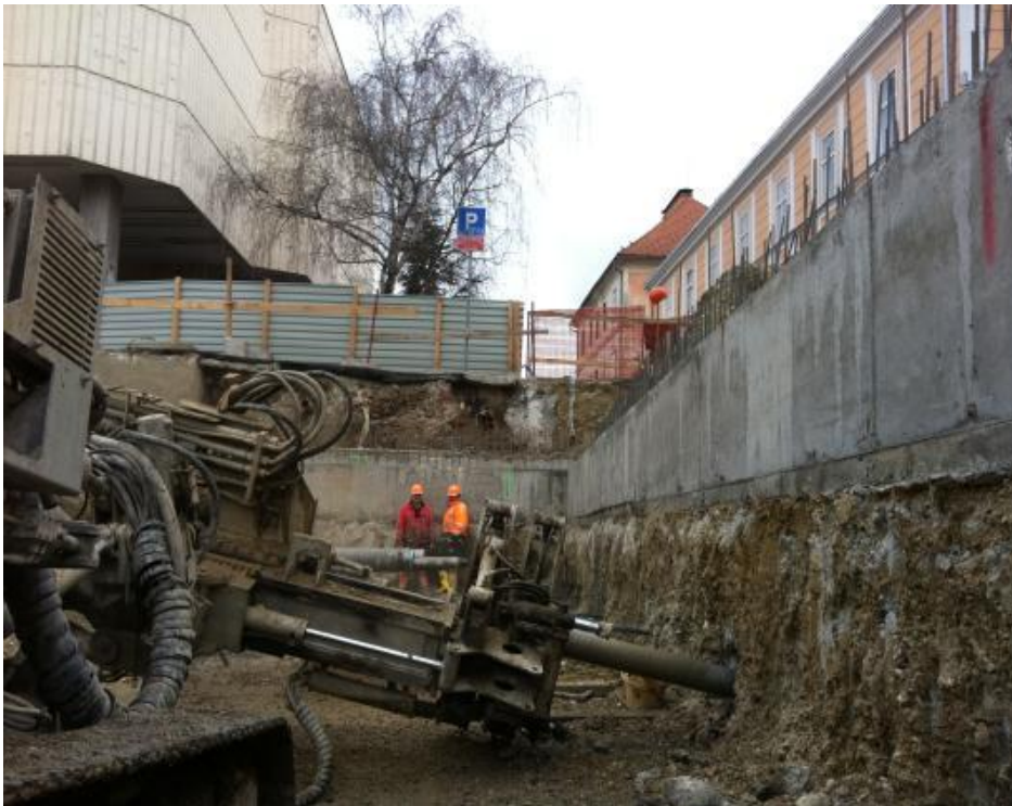
Slika 19. Ugradnja geotehničkih sidara
