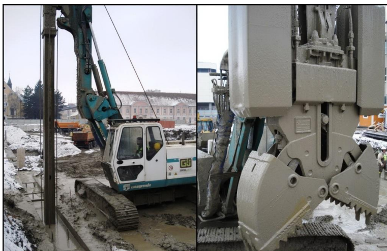
Slika 11. Mehanička grabilica CMX [9]
