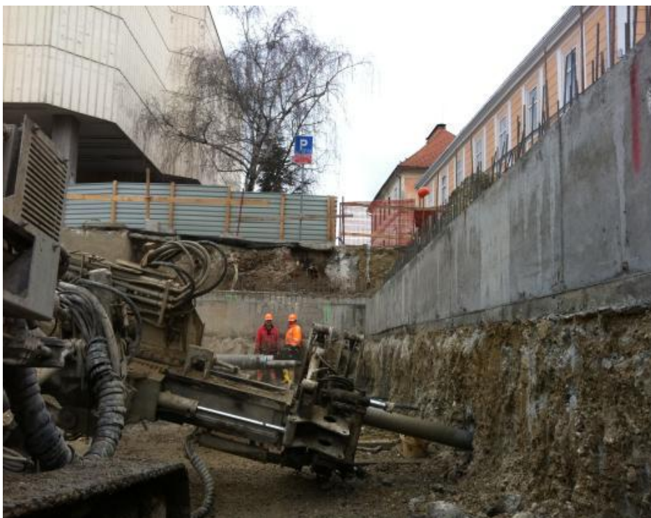
Slika 19. Ugradnja geotehničkih sidara
