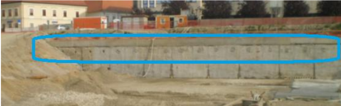
Slika 22. Geotehnička sidra ( Ban centar Zagreb)
