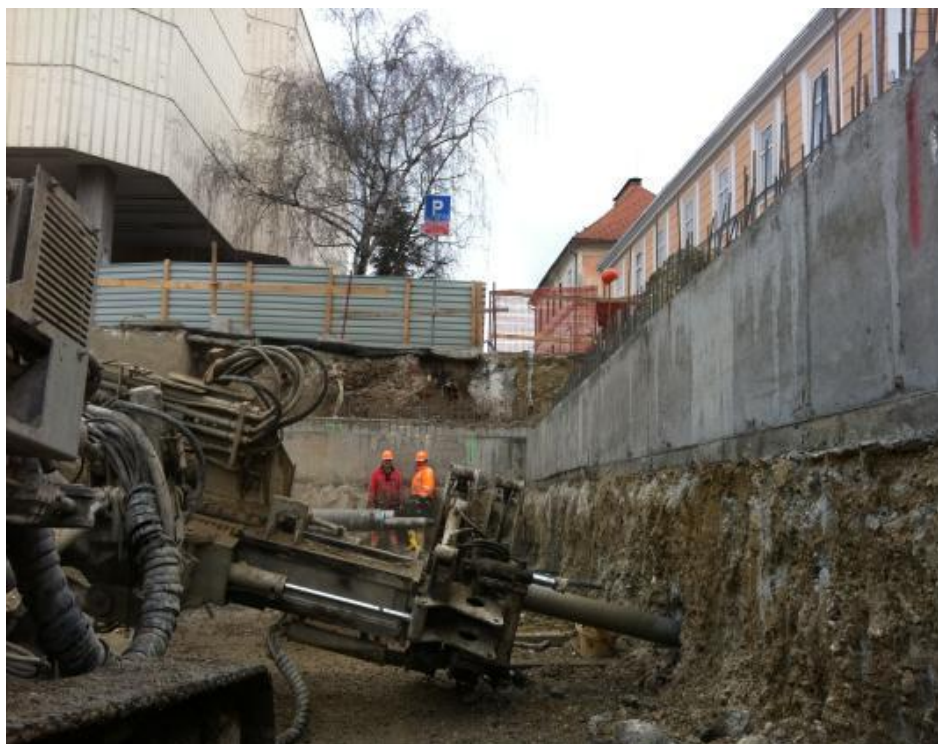
Slika 19. Ugradnja geotehničkih sidara
