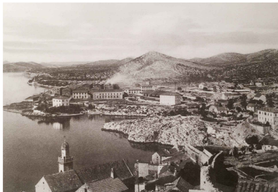
Tvornički kompleks u Crnici
