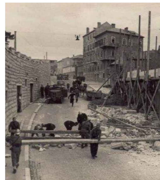
Izgradnja ceste u Šibeniku, 1857. god.
