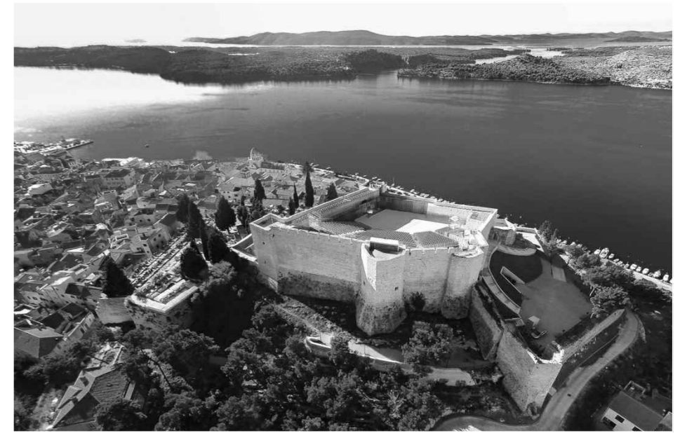
Tvrđava sv. Mihovila nakon obnove
