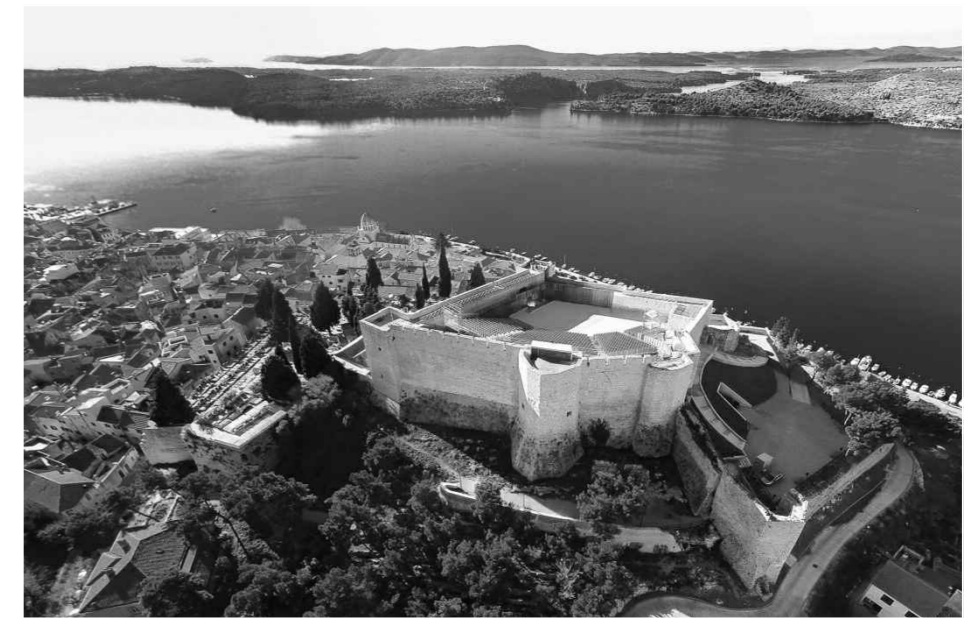
Tvrđava sv. Mihovila nakon obnove
