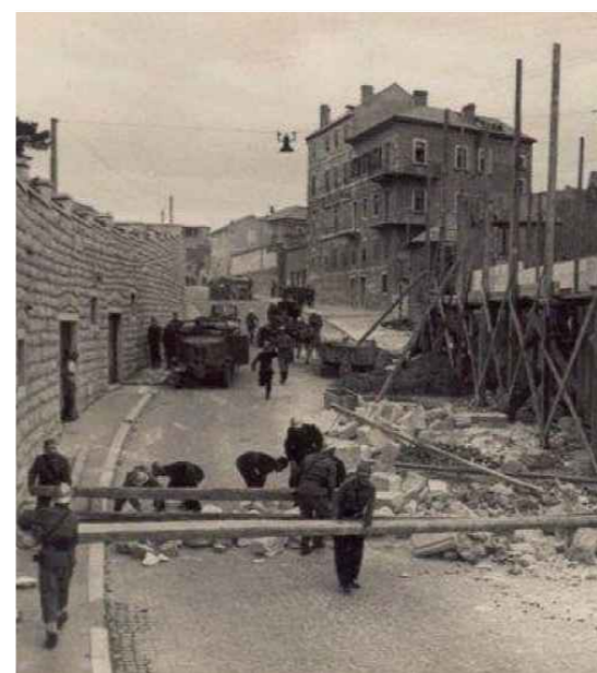
Izgradnja ceste u Šibeniku, 1857. god.
