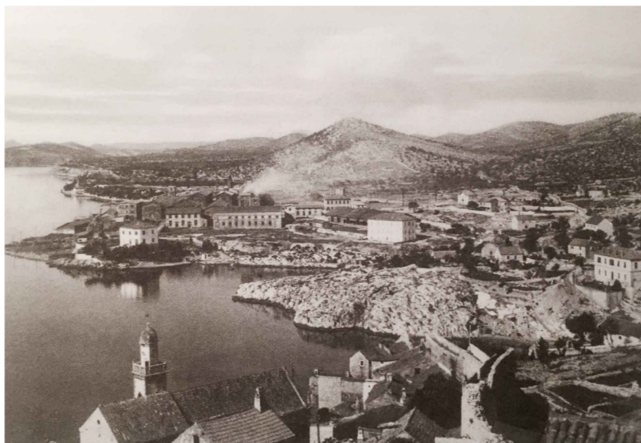
Tvornički kompleks u Crnici
