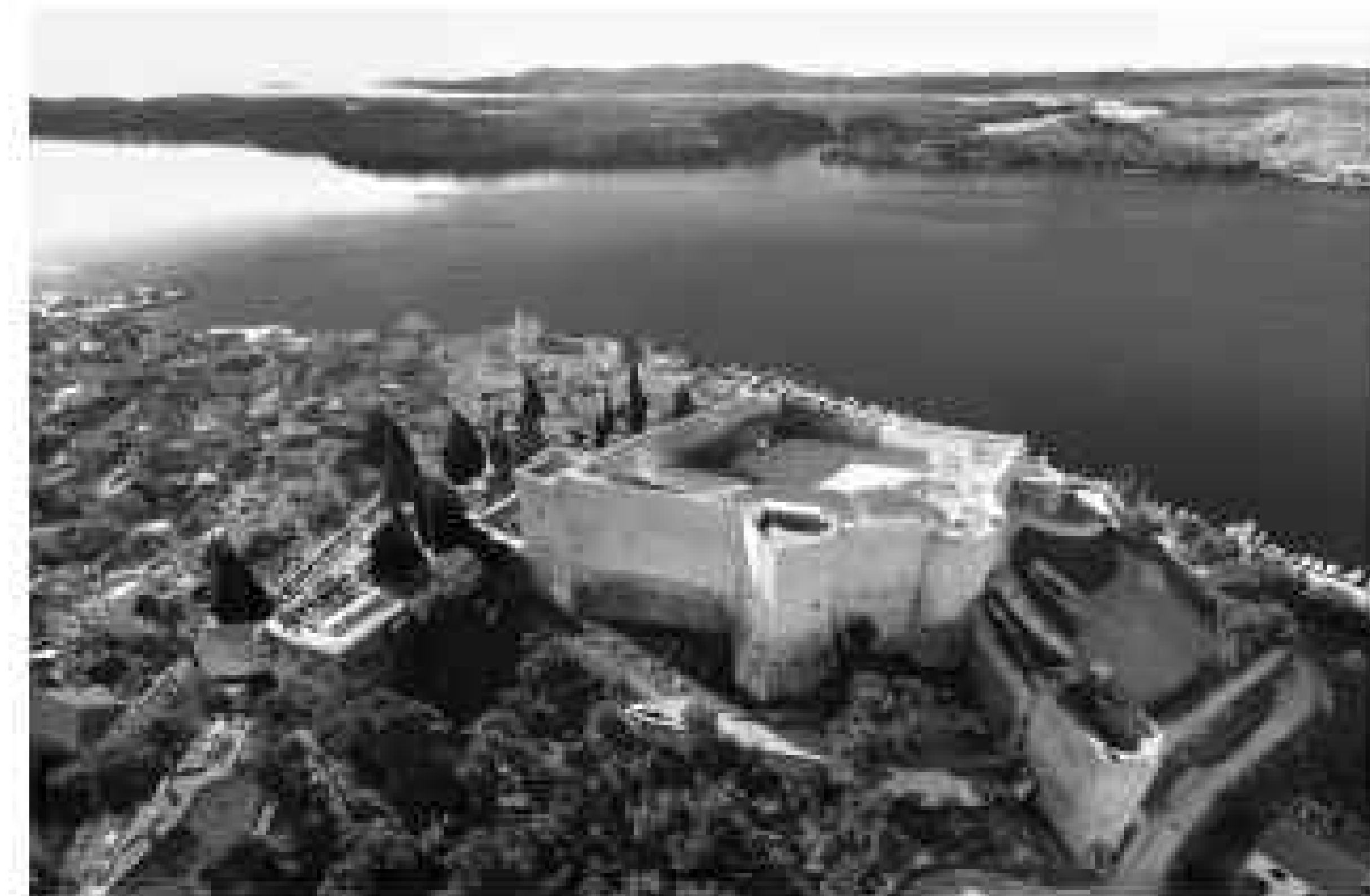
Tvrđava sv. Mihovila nakon obnove
