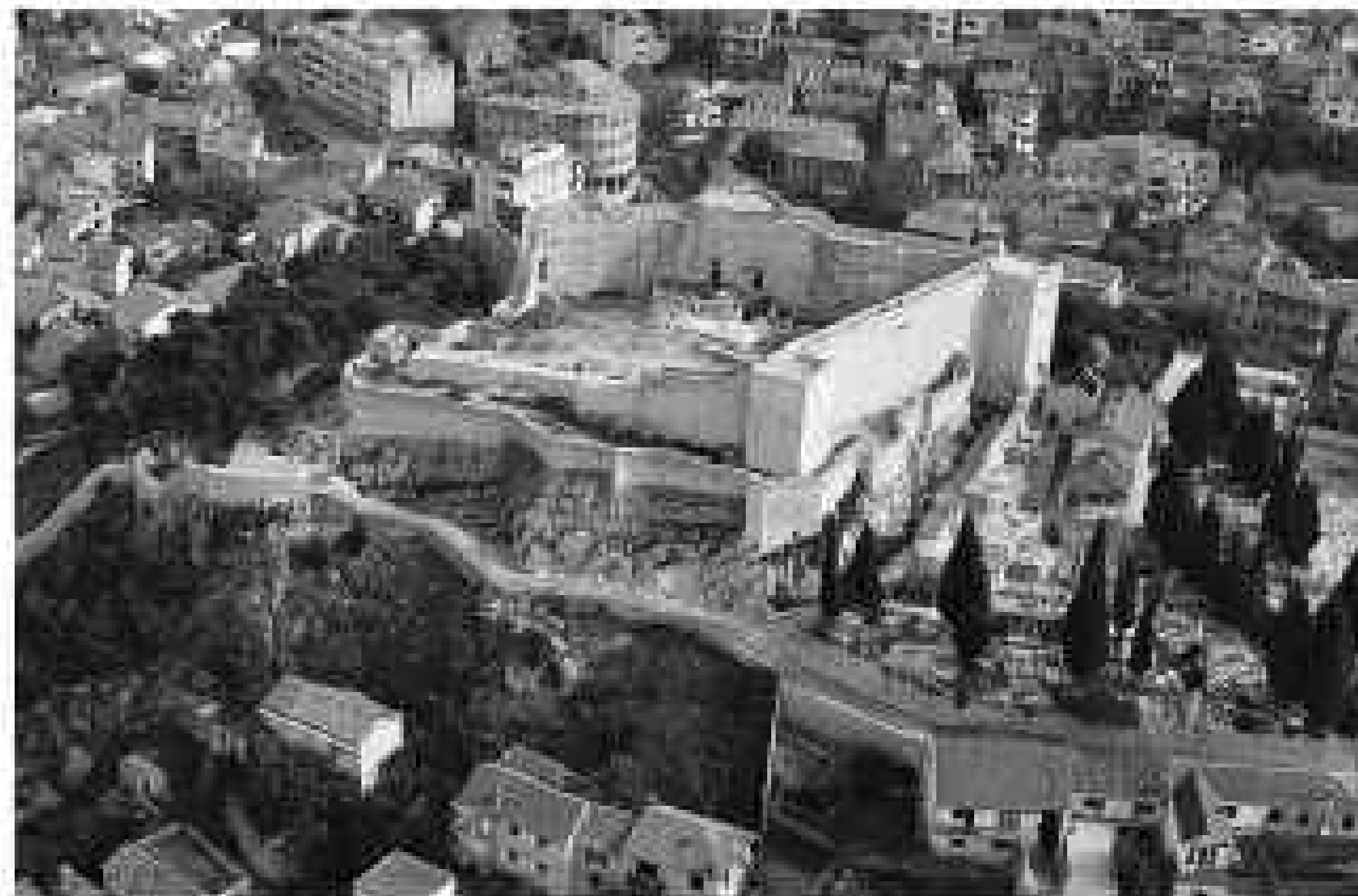
Tvrđava sv. Mihovila prije obnove
