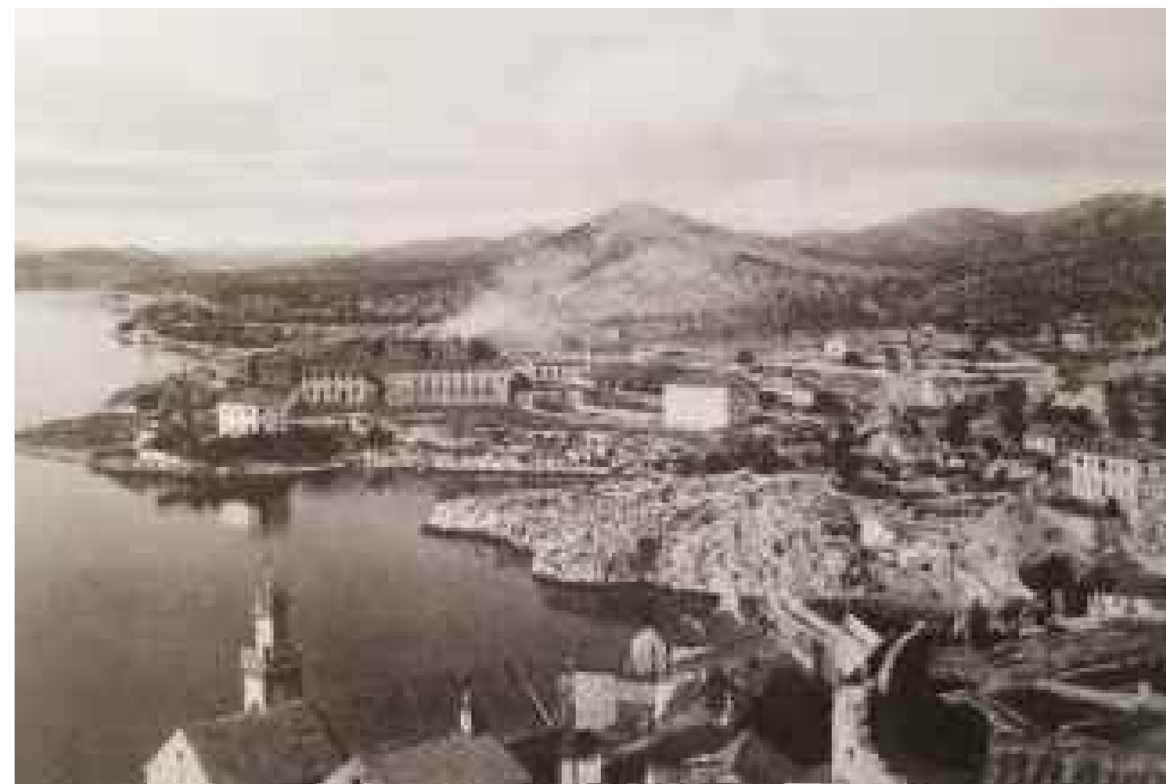
Tvornički kompleks u Crnici
