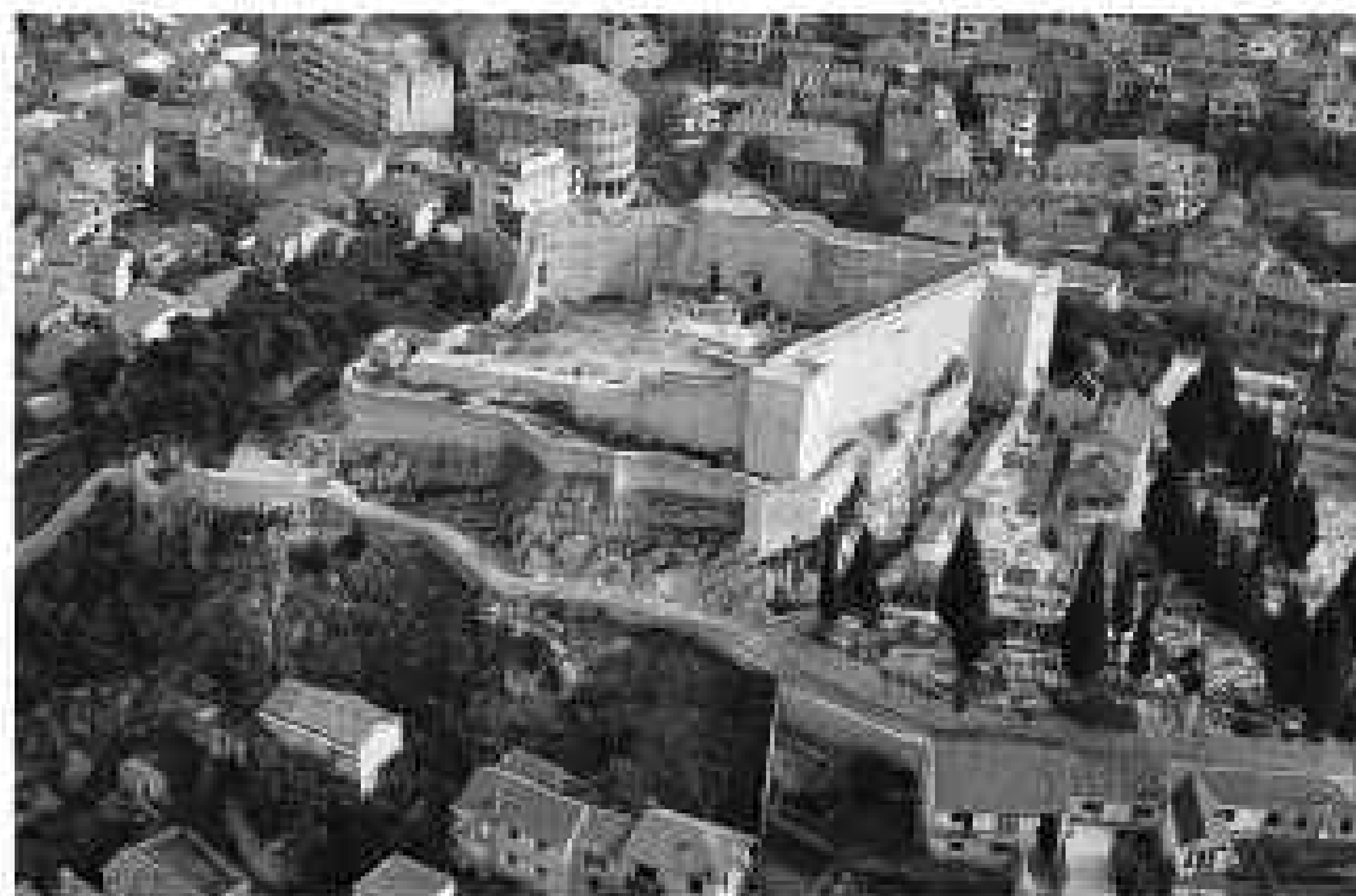
Tvrđava sv. Mihovila prije obnove
