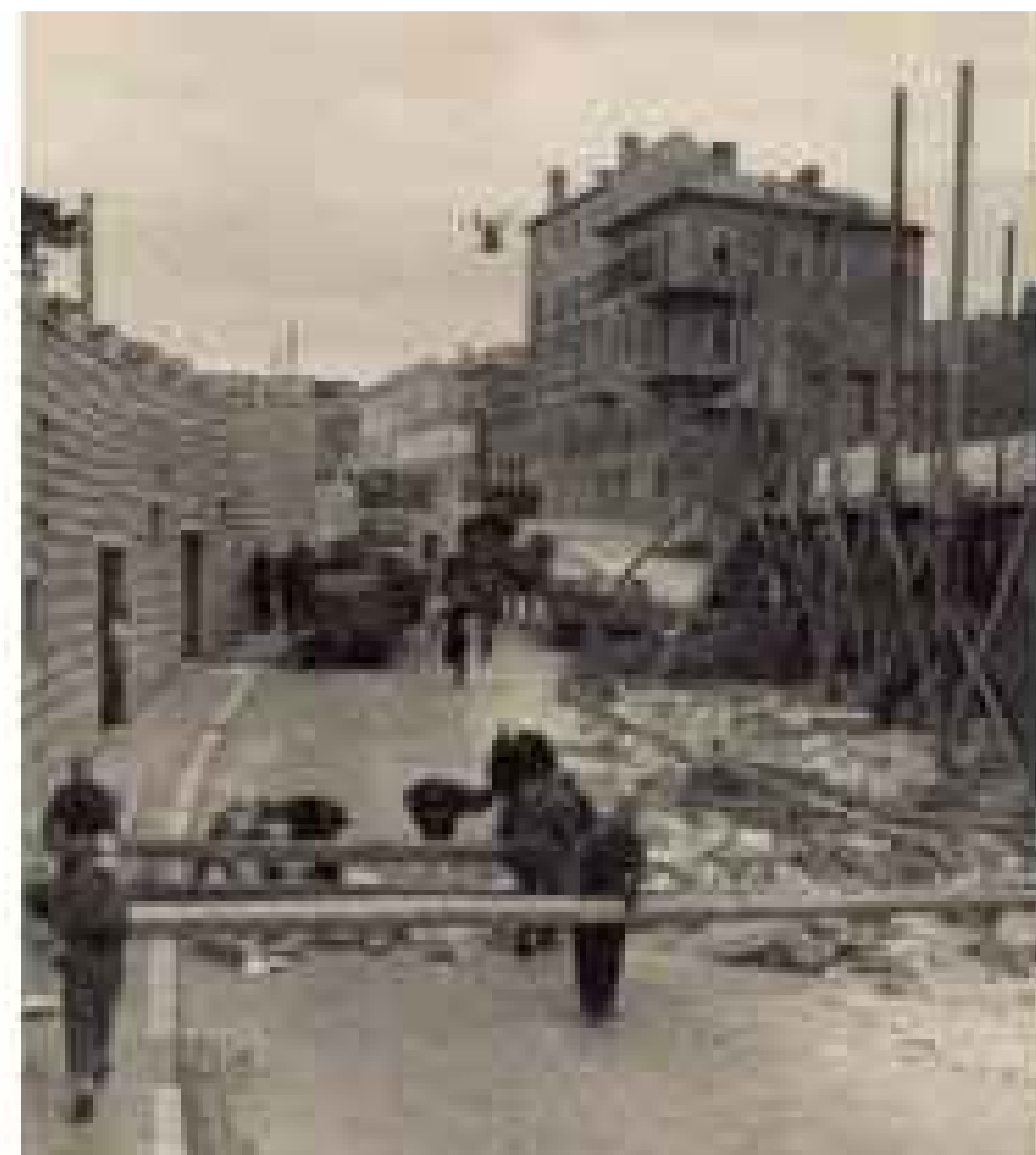
Izgradnja ceste, 1857. god
