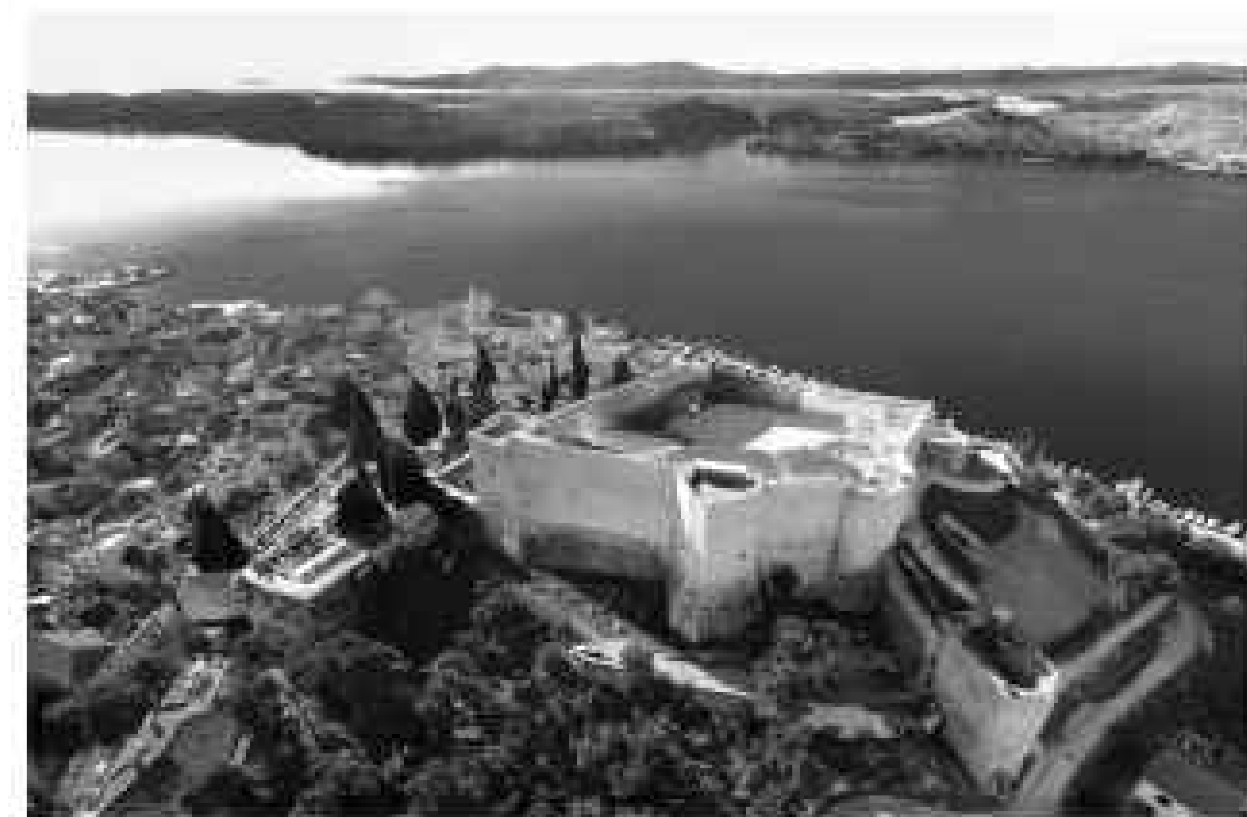
Tvrđava sv. Mihovila nakon obnove
