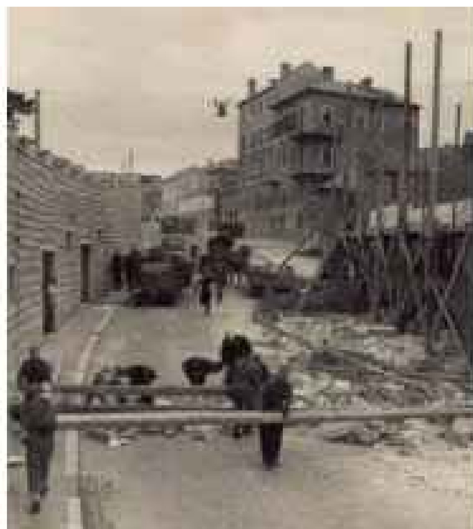
Izgradnja ceste, 1857. god
