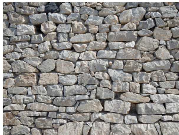
BENKOVAČKI KAMEN ( tradicionalno zidanje )
