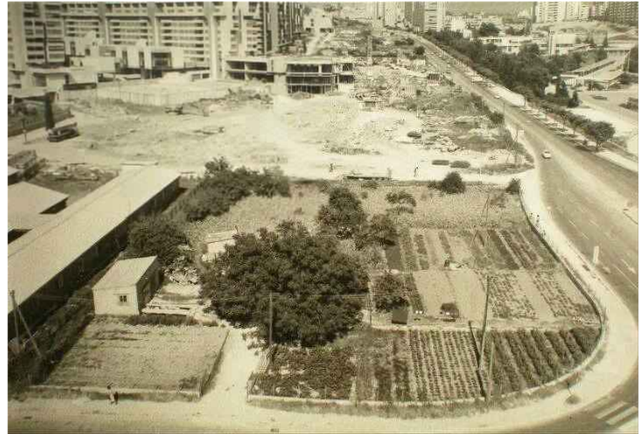
Predmetna lokacija u tijeku gradnje Splaya III
