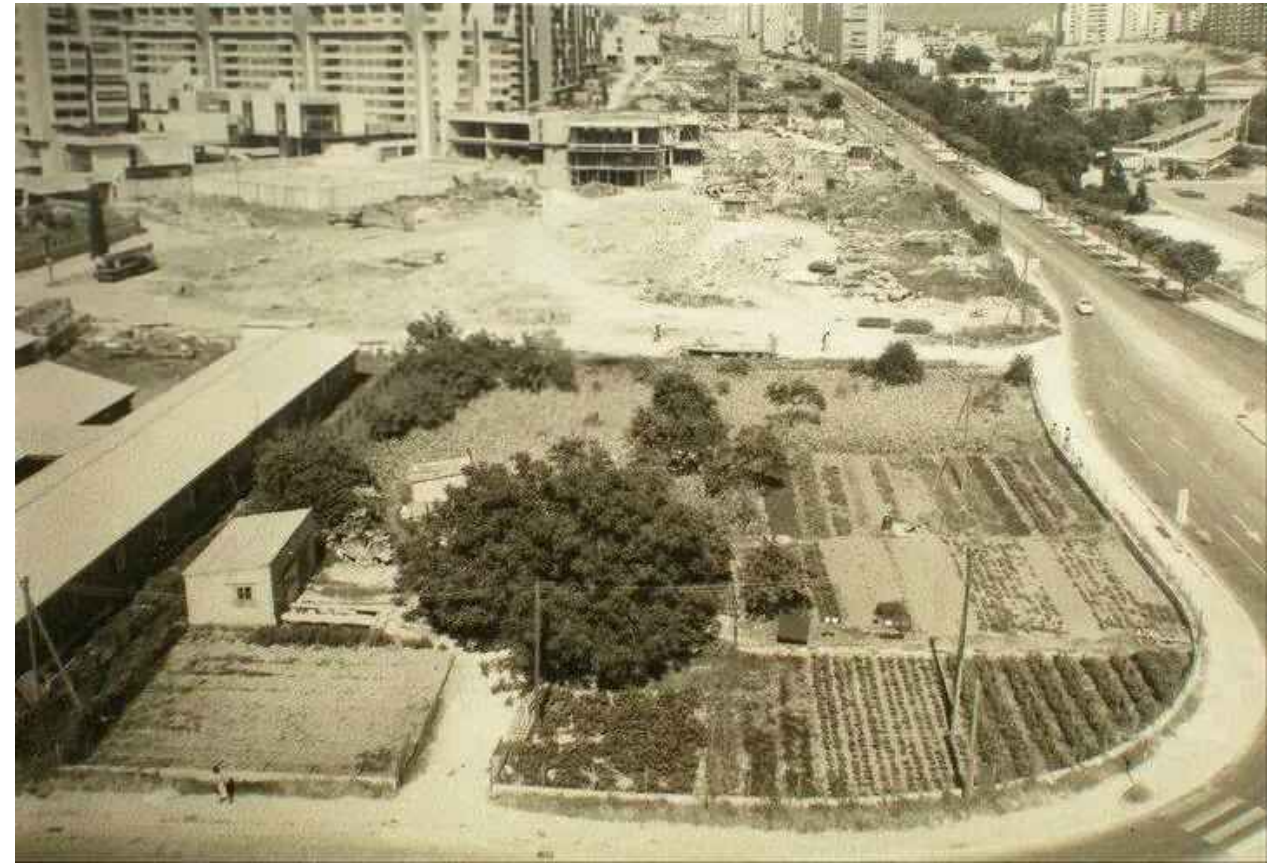
Predmetna lokacija u tijeku gradnje Splaya III
