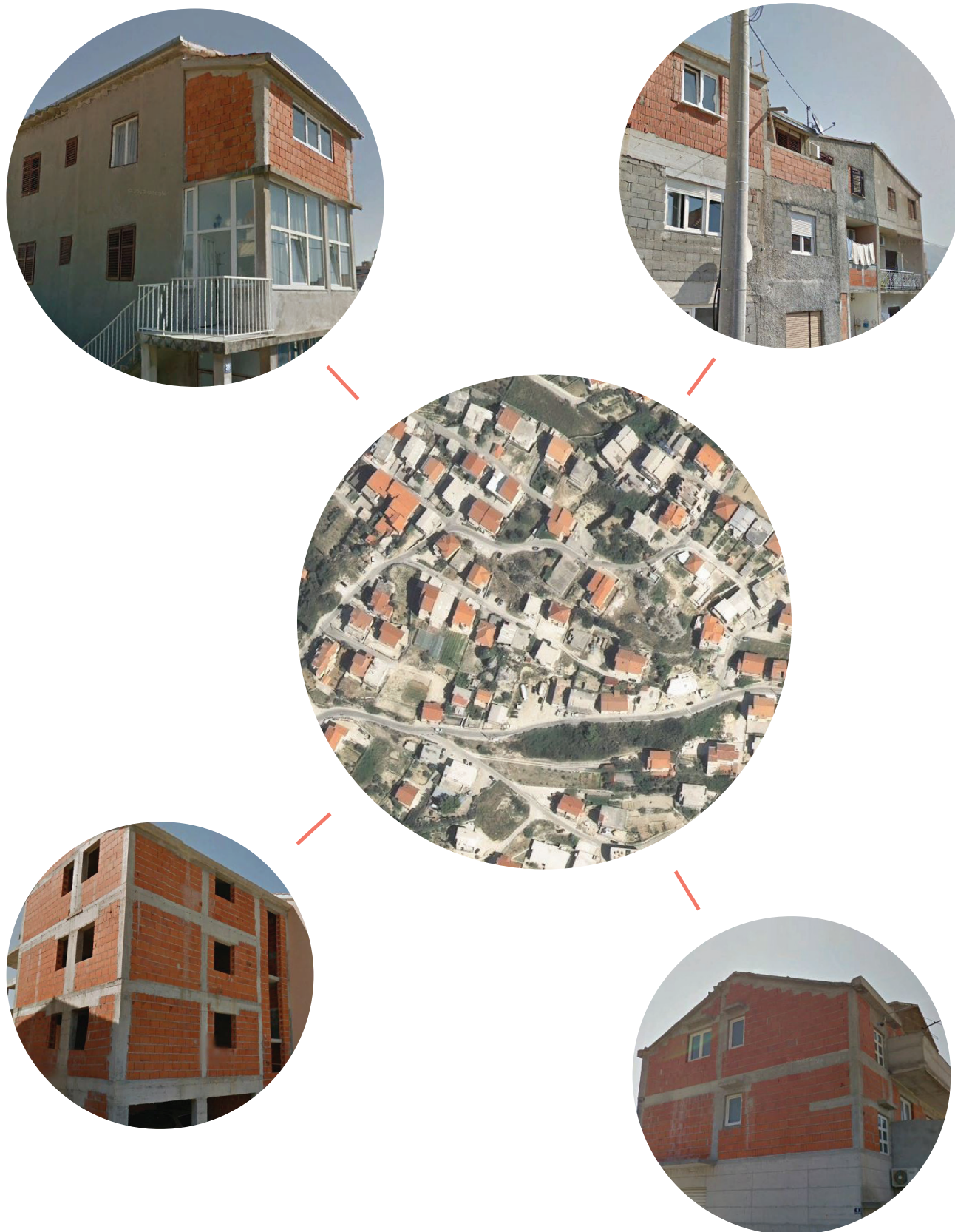
sl 28. primjeri nedovršene ilegalne stambene izgradnje
