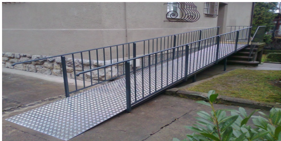
Slika 6.1. Rampa za invalide
