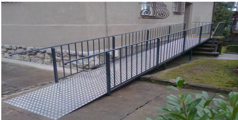
Slika 6.1. Rampa za invalide
