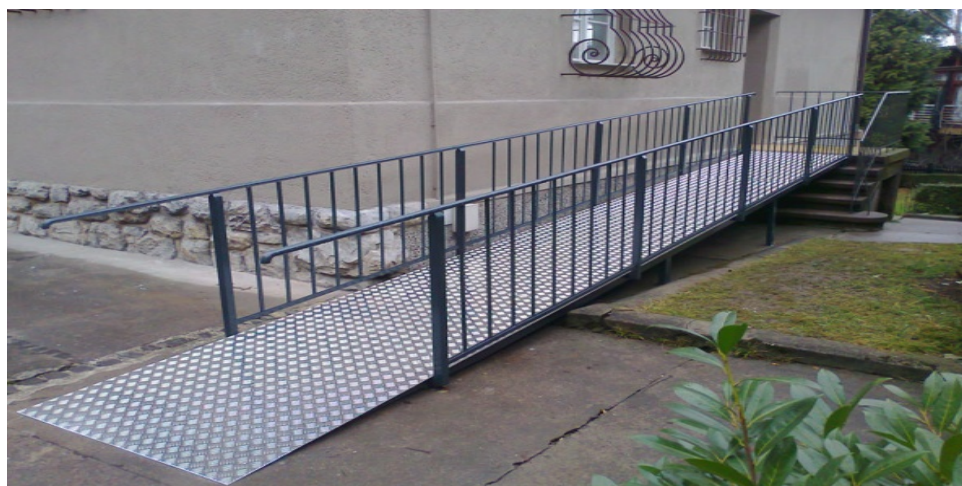
Slika 6.1. Rampa za invalide
