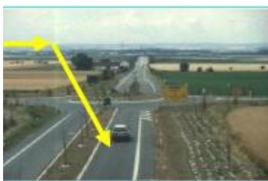
**Slika 20.** Okomiti prilaz jednotračnom kružnom toku
