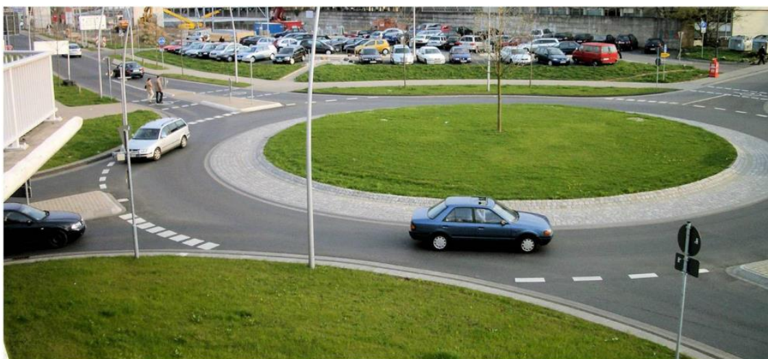
Slika 13. Moderni jednostručni kružni tok
