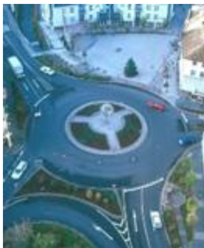
Slika 37. Moderni dvotračni kružni tok
