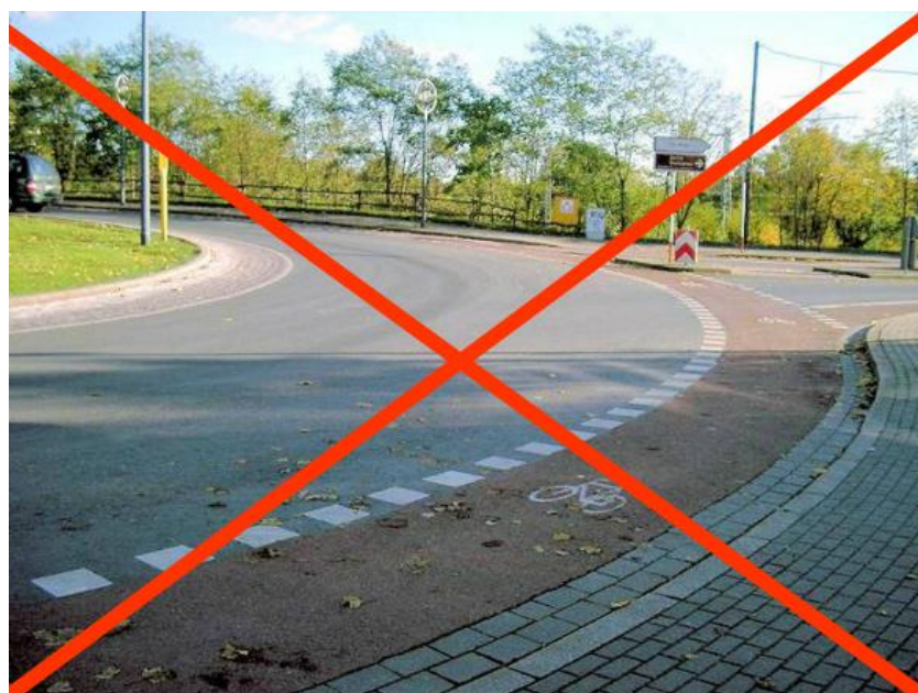
Slika 24. Pogrešno postavljanje biciklističke staze
