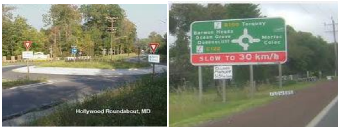
Slika 5. Smanjenje ulaznih brzina
