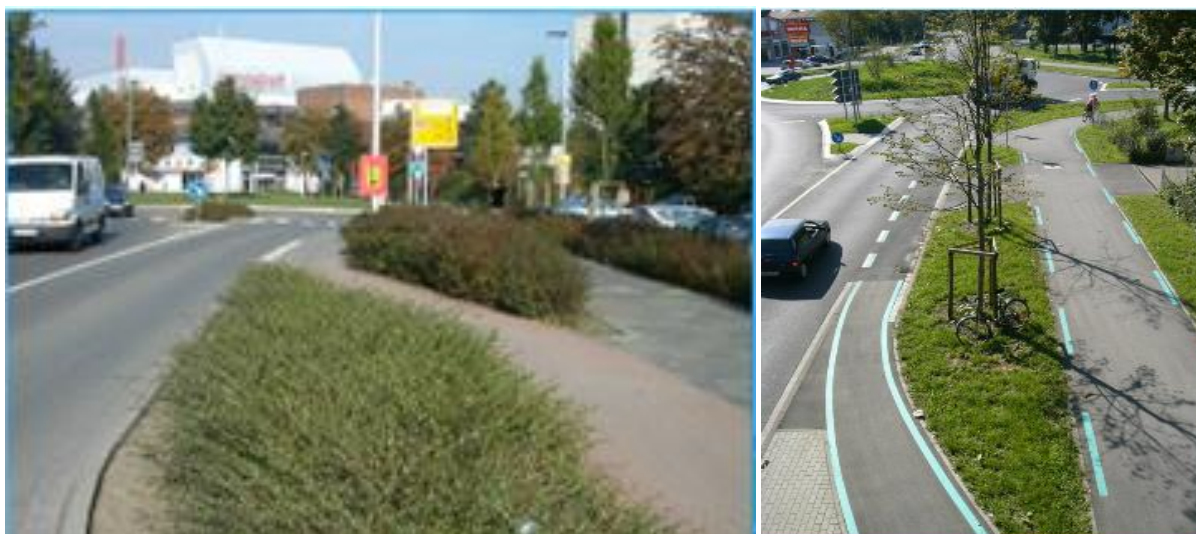
Slika 26. Usmjeravanje biciklističke staze na cestu
