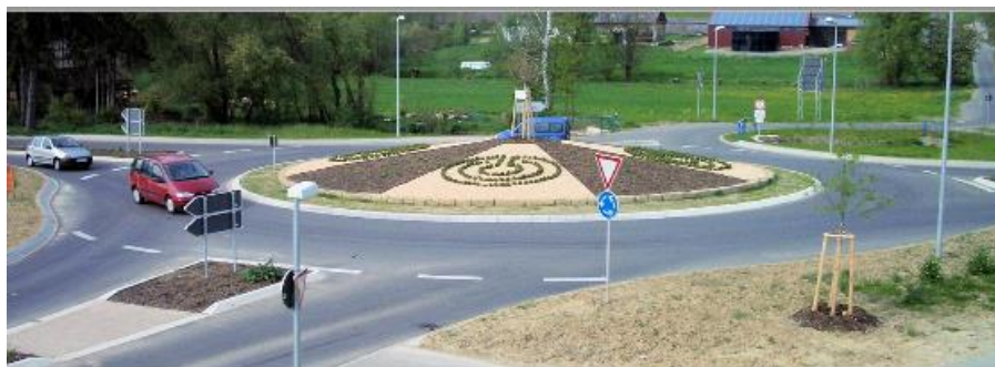
Slika 19. Uobičajeni ruralni jednotračni kružni tok
