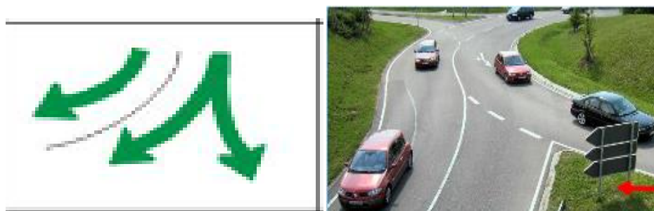
Slika 43. Izlazak iz turbo kružnog toka
