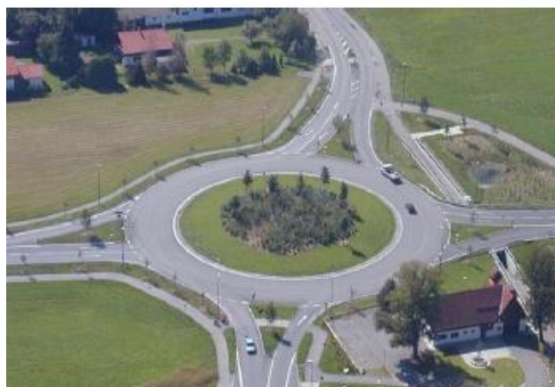
Slika 36. Ruralni dvotračni kružni tok u Bad Aiblingu
