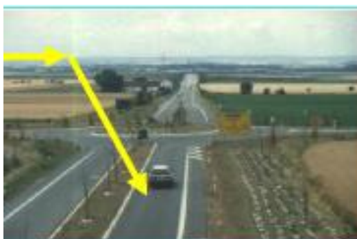
Slika 20. Okomiti prilaz jednotračnom kružnom toku
