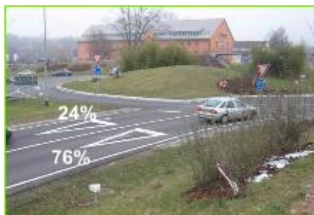
**Slika 45.** Postotak korištenja pojedinog voznog traka prilikom ulaska
